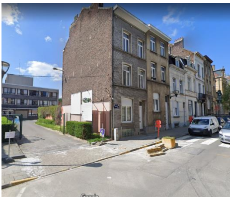
Toegang tot de Fr. Delcoignestraat
