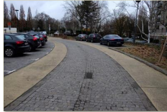
PHOTO DE L'AMÉNAGEMENT DE LA RUE ESSEGHEM SOURCE : SERVICE DU CONTRAT DE QUARTIER DE JETTE
