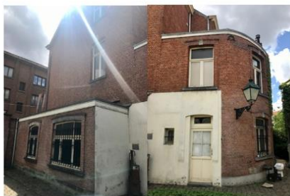
Bâtiment principal – façade vers le jardin
