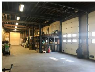
Bâtiment principal – rez-de-chaussée côté rue
