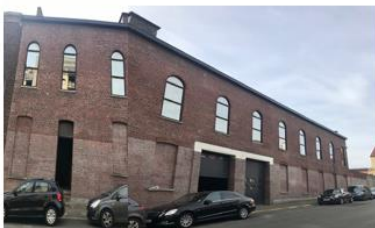
Bâtiment principal – façade principale
