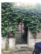
3. Accès bâtiment annexé
