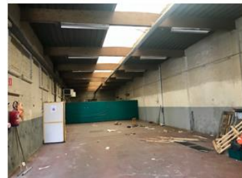
Bâtiment principal – rez-de-chaussée arrière
