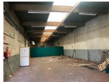
Hoofdgebouw - benedenverdieping achterkant
