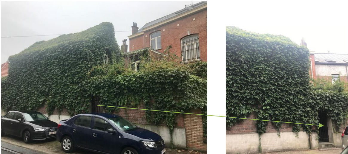
Afbeelding 2 - zijde Henri Van Hammestraat (toegang tot het binnenterrein van het huizenblok: er is momenteel een poort in traliewerk onder de begroeiing)
