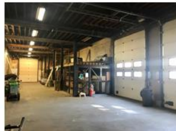
Hoofdgebouw - benedenverdieping straatkant
