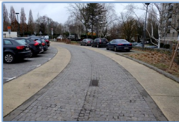
Foto van de heraanleg van de Esseghemstraat
