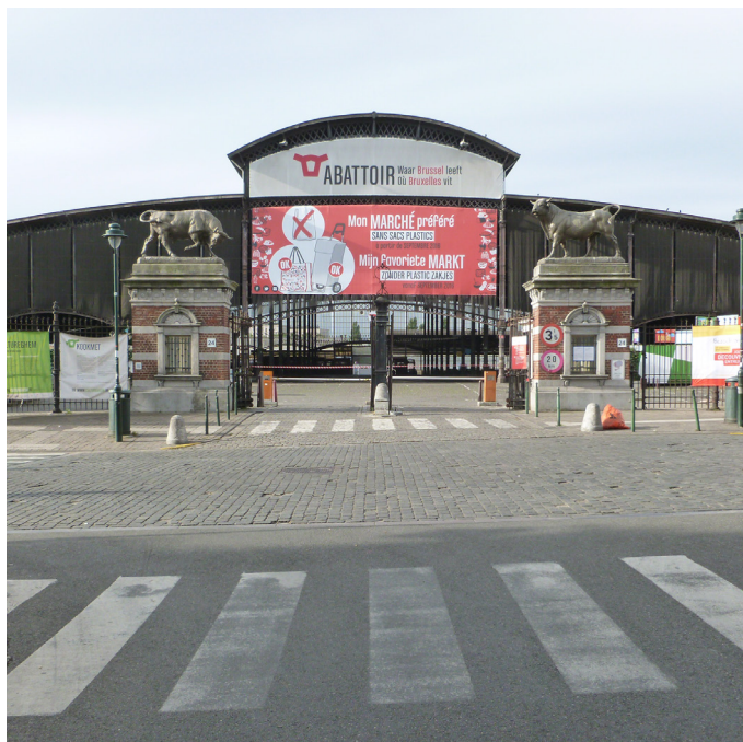
- foto van de bestaande toestand -
