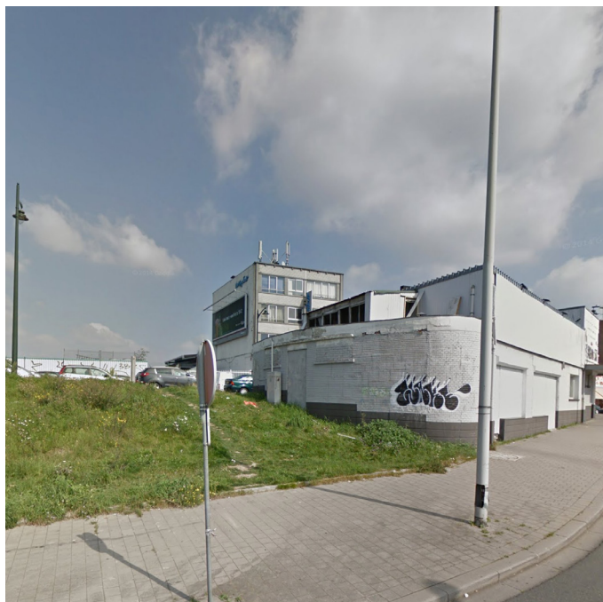
- foto van de bestaande toestand -
