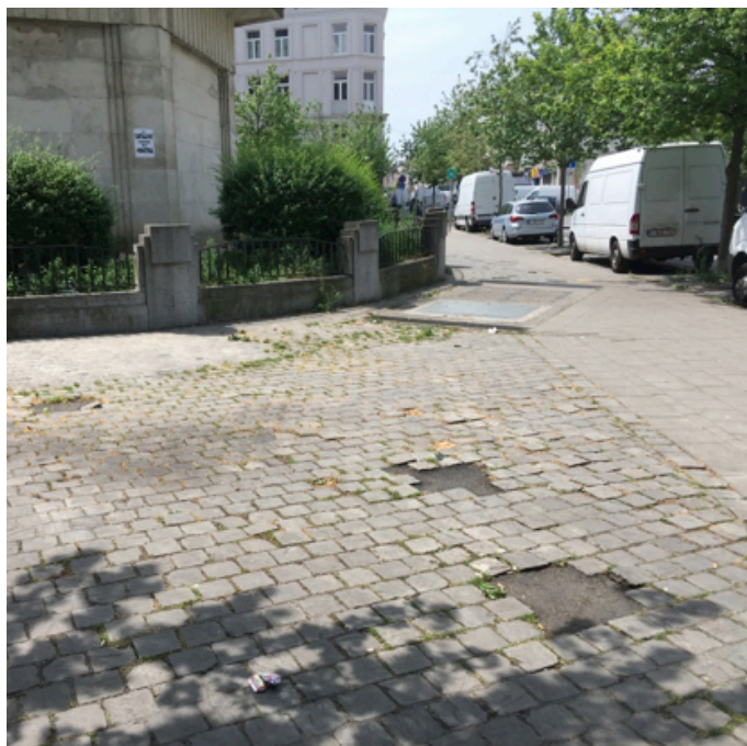
- foto van de bestaande toestand -
