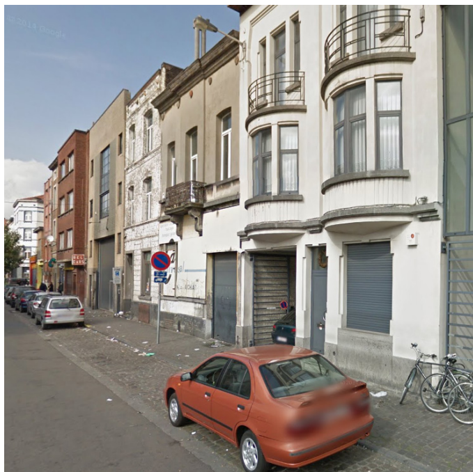
- foto van de bestaande toestand -
