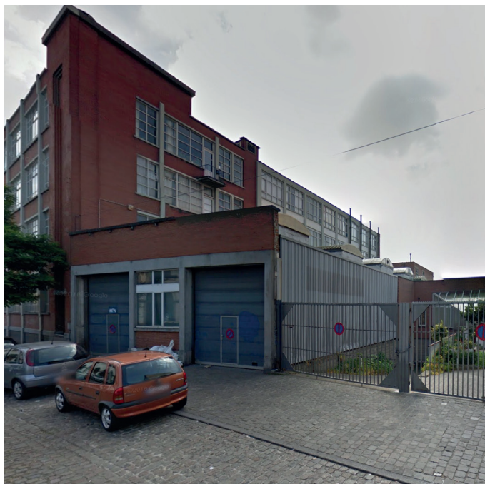
- photo de la situation existante -
