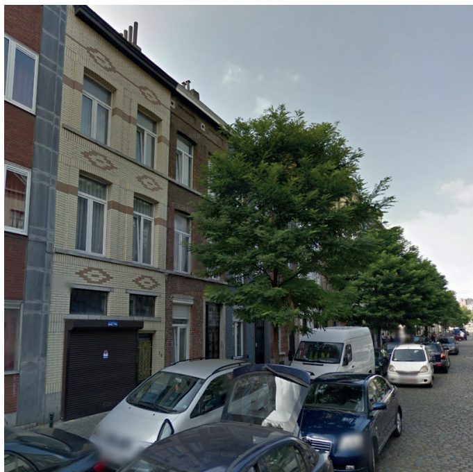
- photo de la situation existante -
