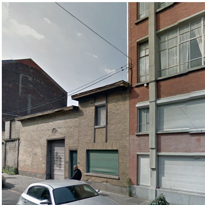
- photo de la situation existante -
