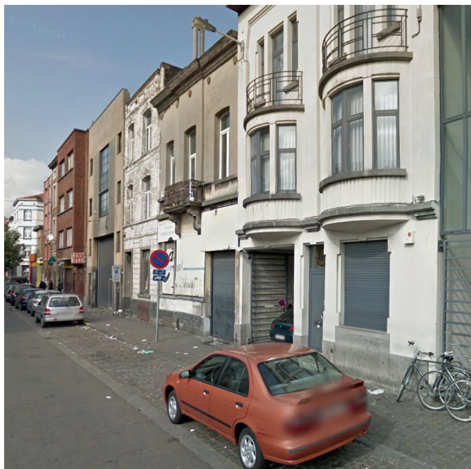
- photo de la situation existante -
