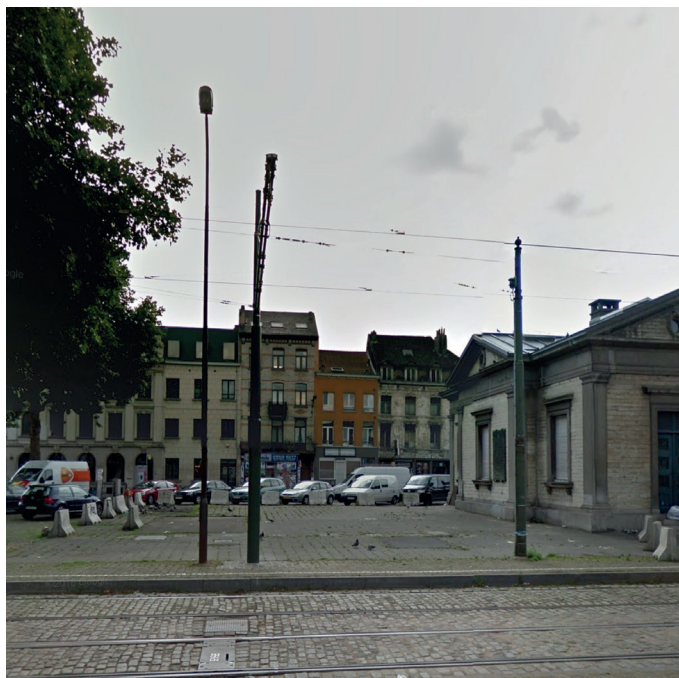
- photo de la situation existante -
