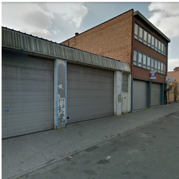
- photo de la situation existante -
