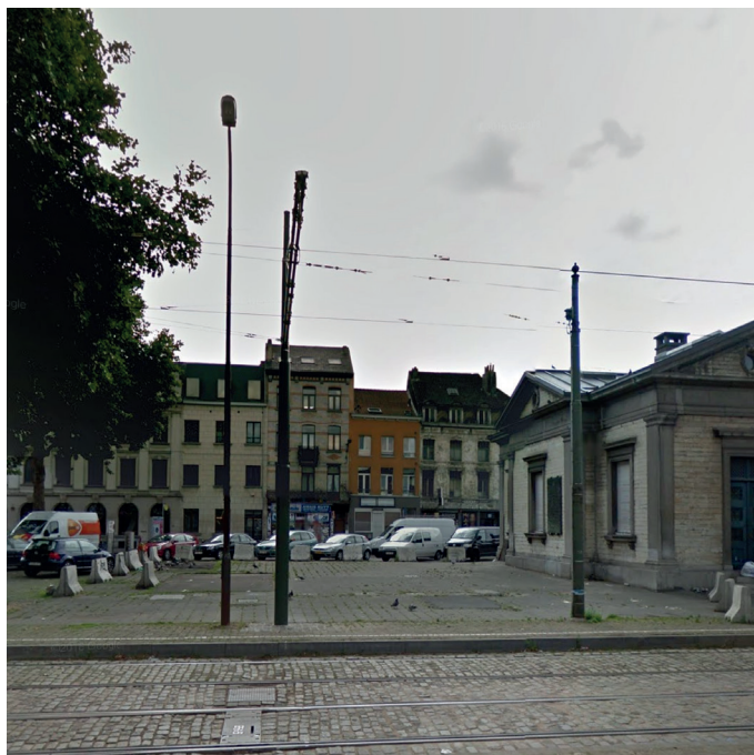
- photo de la situation existante -
