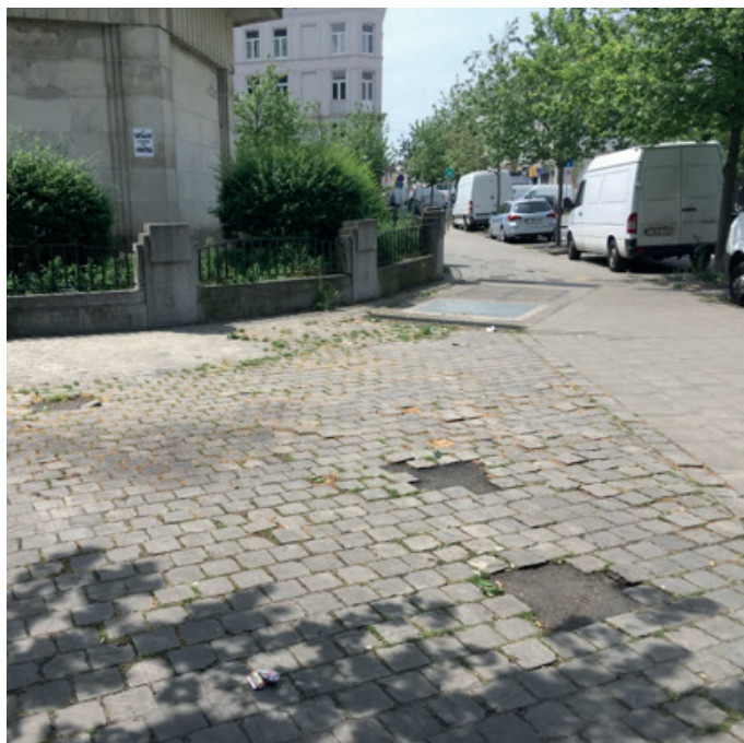
- photo de la situation existante -
