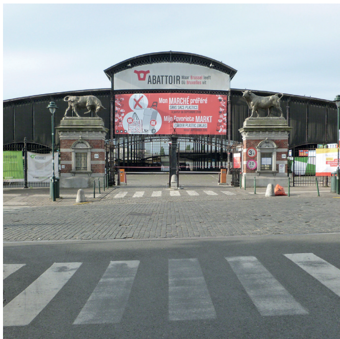
- photo de la situation existante -
