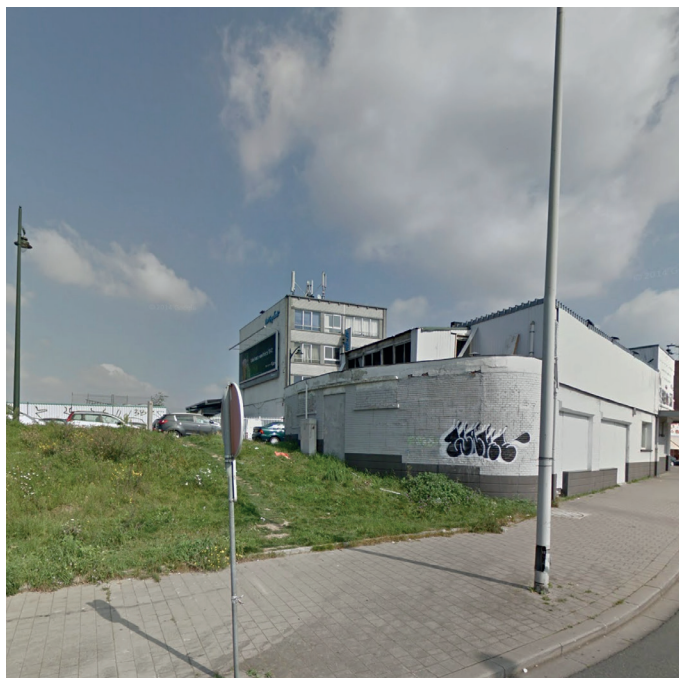
- photo de la situation existante -
