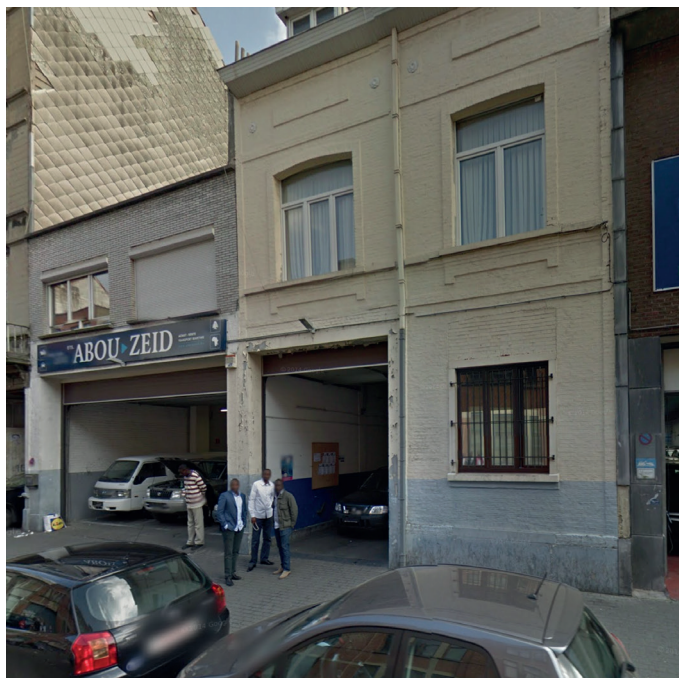
- photo de la situation existante -
