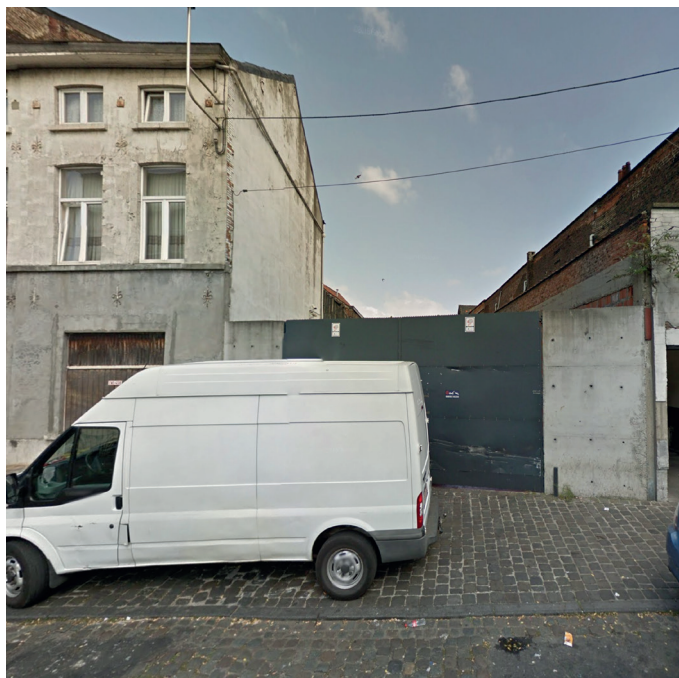
- photo de la situation existante -
