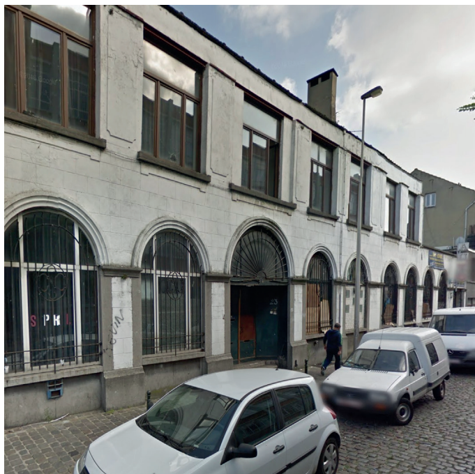
- photo de la situation existante -
