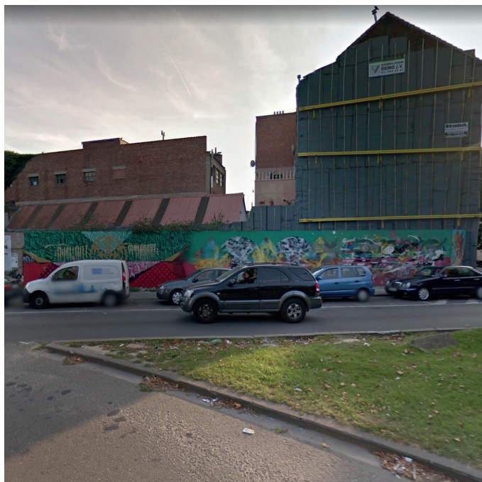
- photo de la situation existante -
