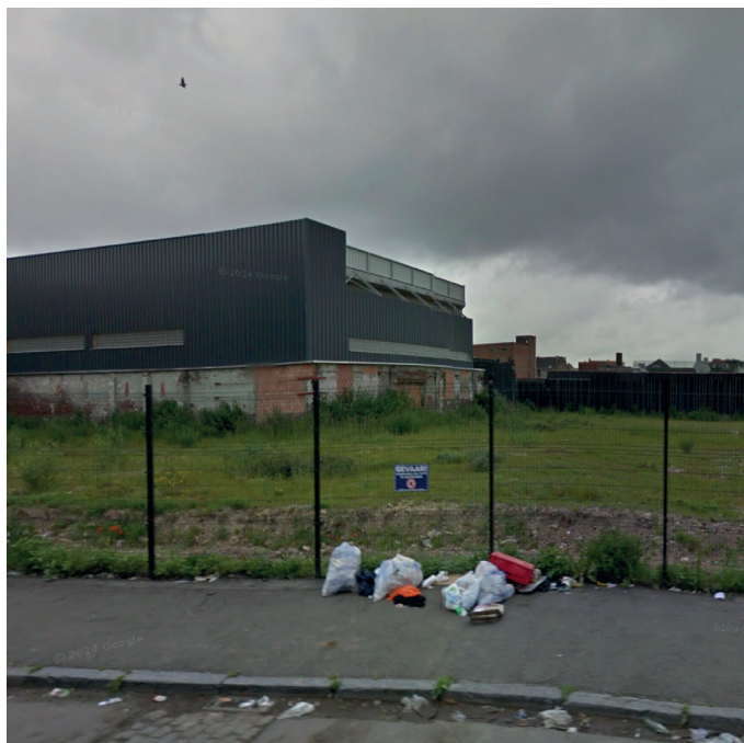
- foto van de bestaande toestand -
