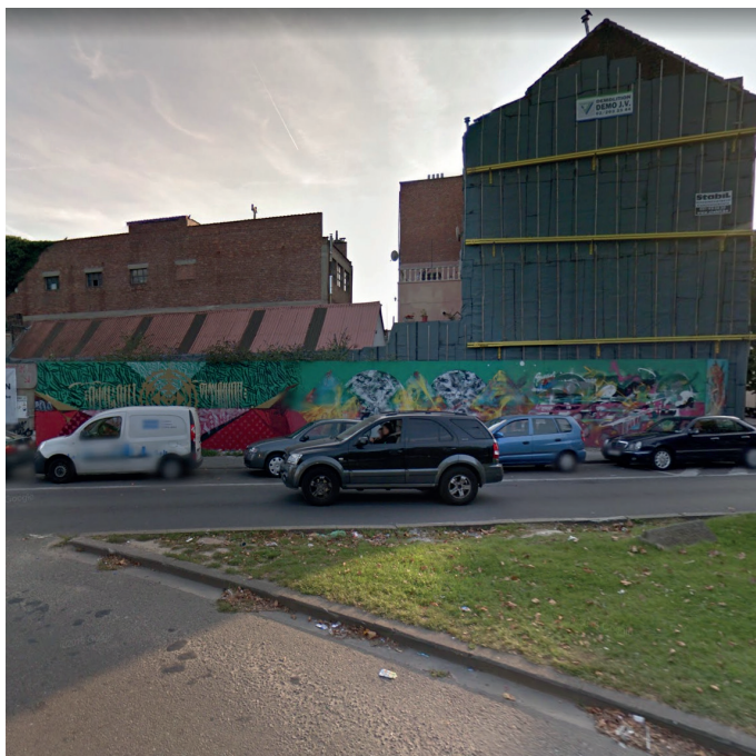
- foto van de bestaande toestand -
