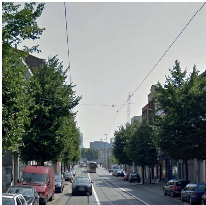
- foto van de bestaande toestand -
