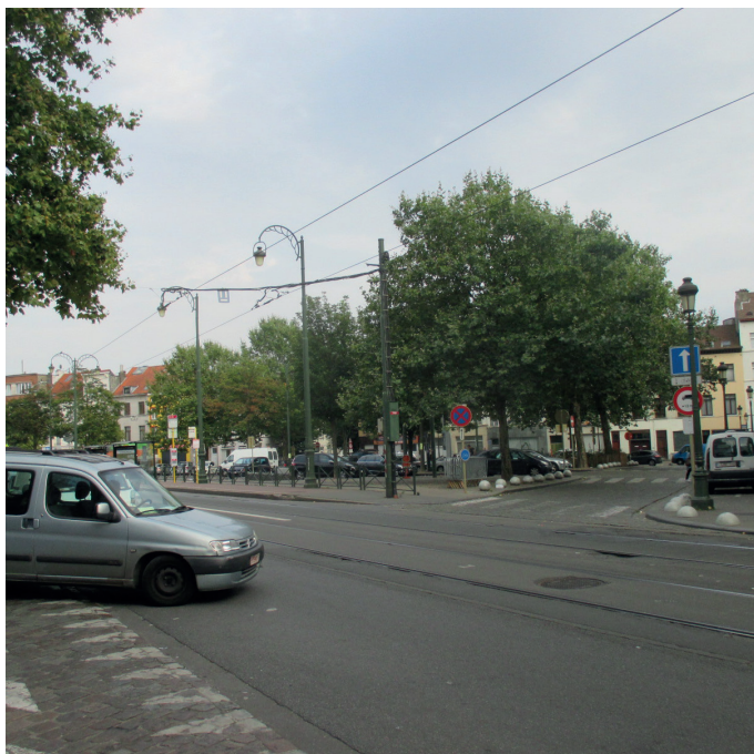
- foto van de bestaande toestand -
