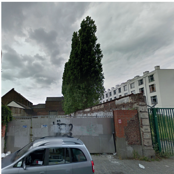
- foto van de bestaande toestand -
