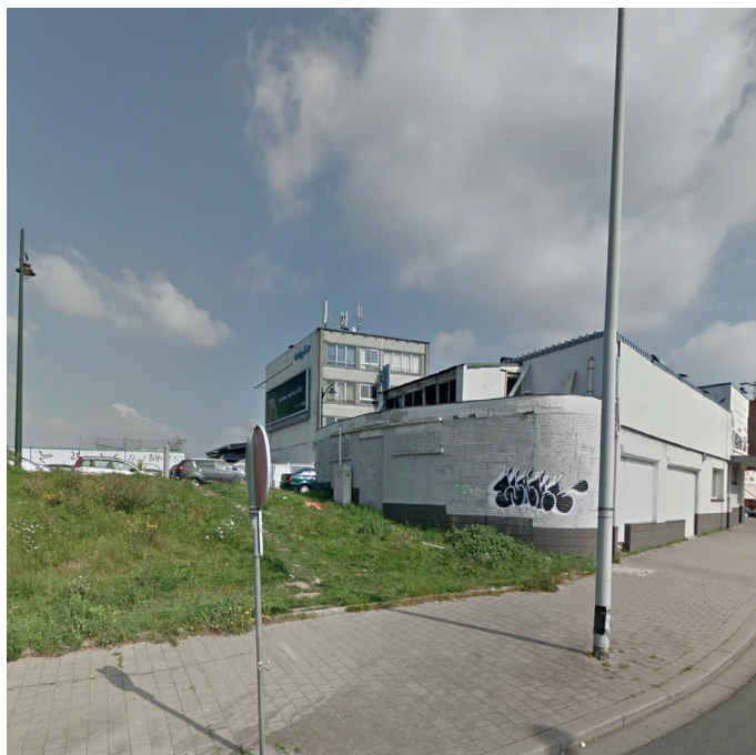
- foto van de bestaande toestand -
