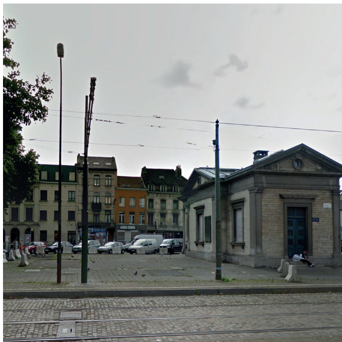
- foto van de bestaande toestand -
