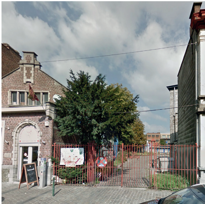
- foto van de bestaande toestand -
