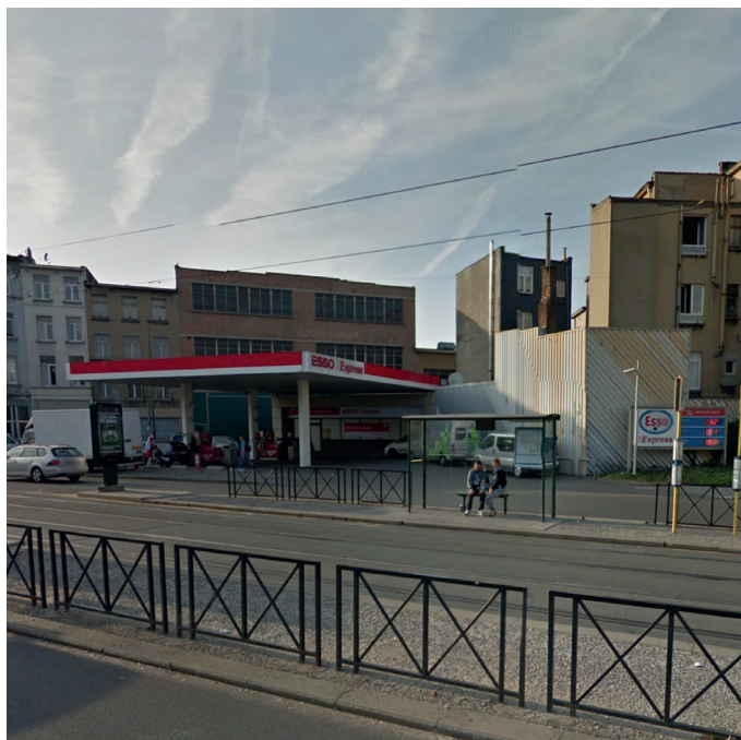
- foto van de bestaande toestand -
