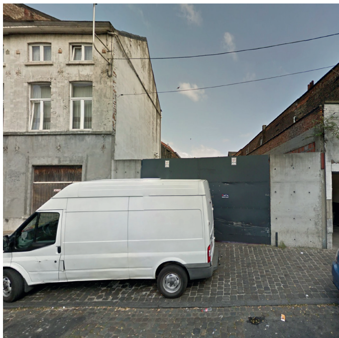
- foto van de bestaande toestand -
