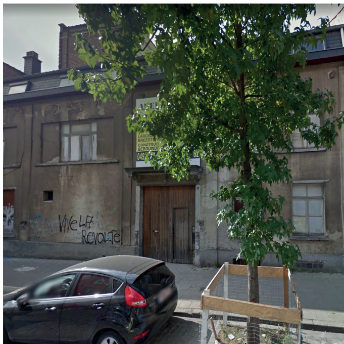
- foto van de bestaande toestand -
