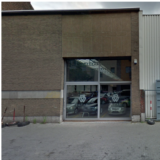
- foto van de bestaande toestand -
