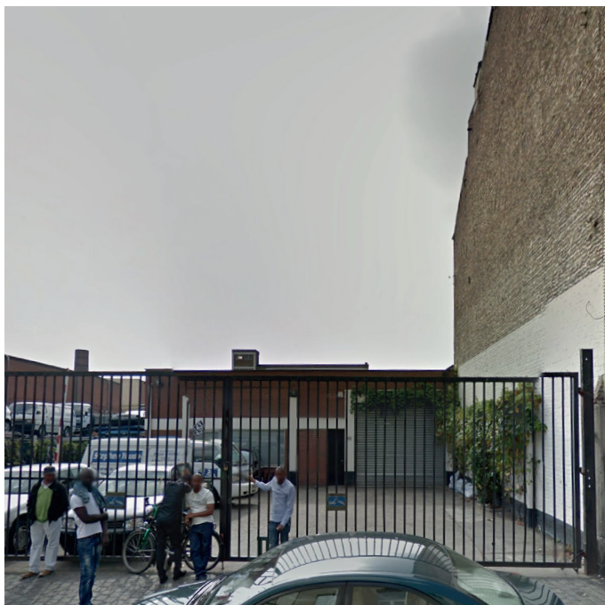
- foto van de bestaande toestand -
