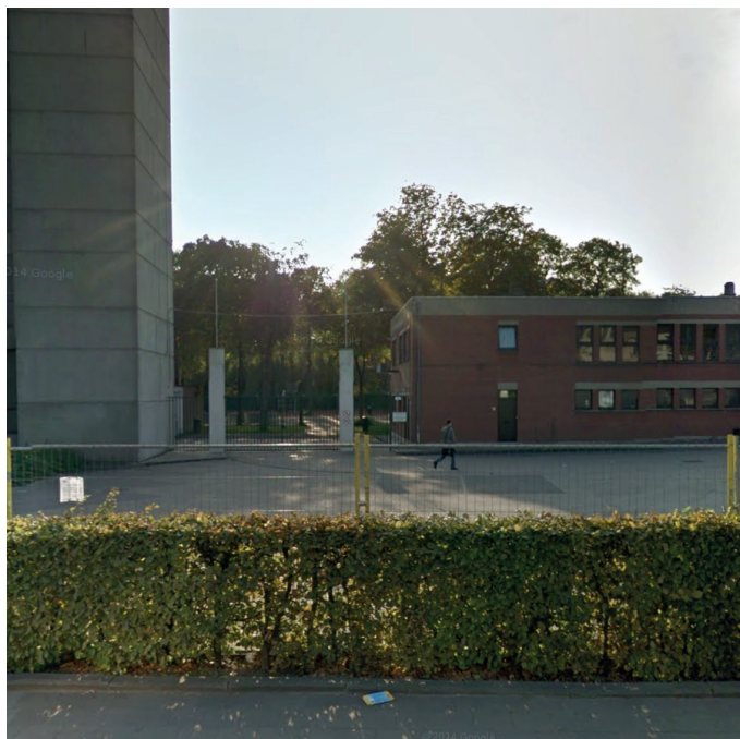
- foto van de bestaande toestand -
