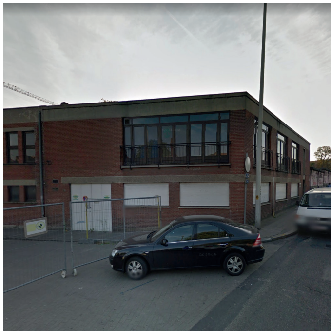
- foto van de bestaande toestand -
