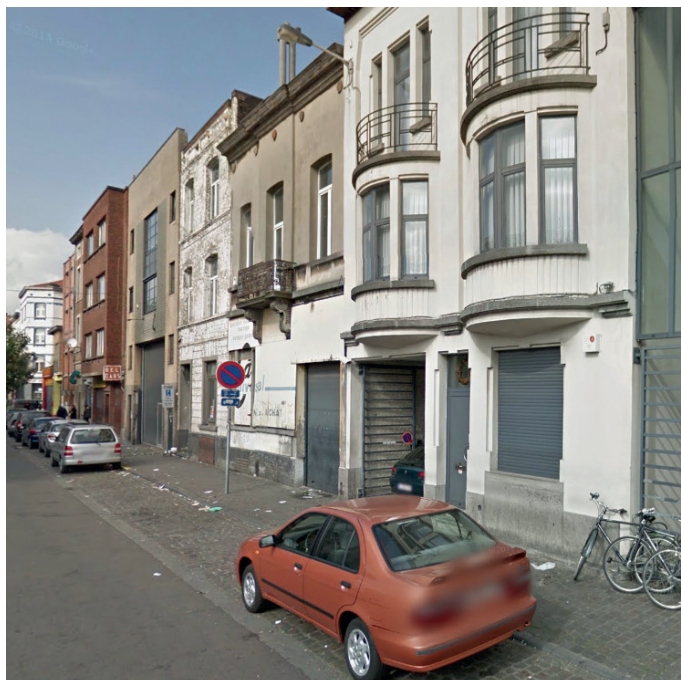
- foto van de bestaande toestand -
