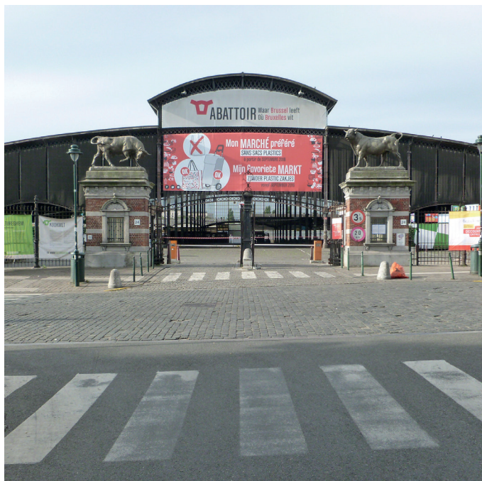
- foto van de bestaande toestand -
