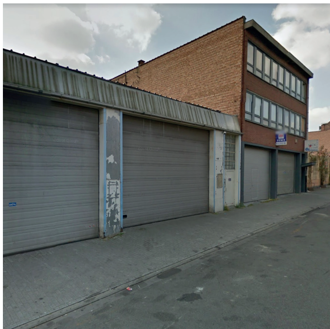
- foto van de bestaande toestand -
