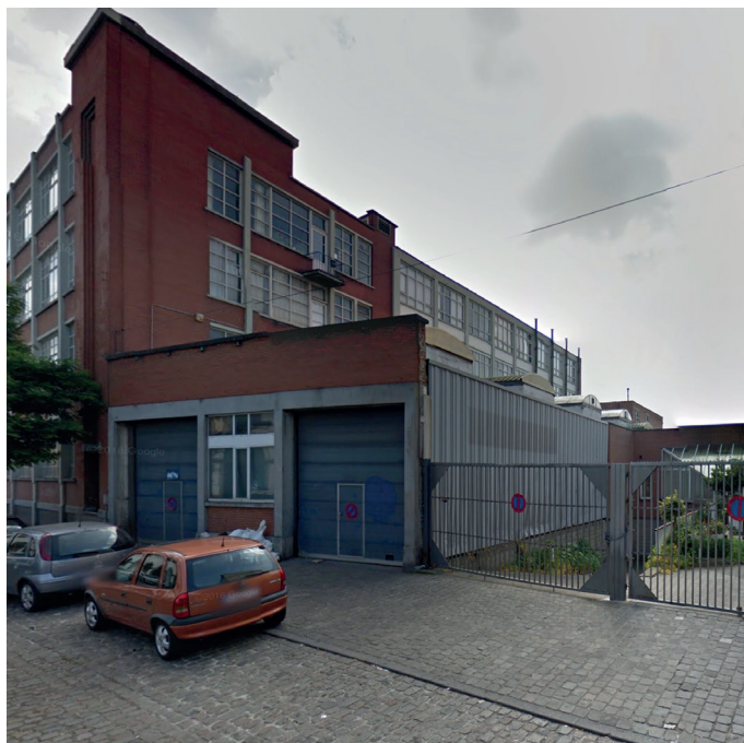
- foto van de bestaande toestand -
