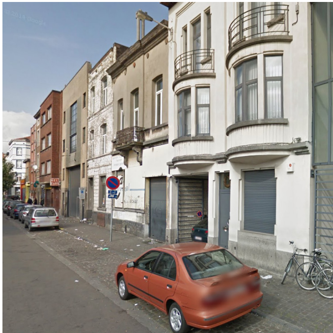
- foto van de bestaande toestand -
