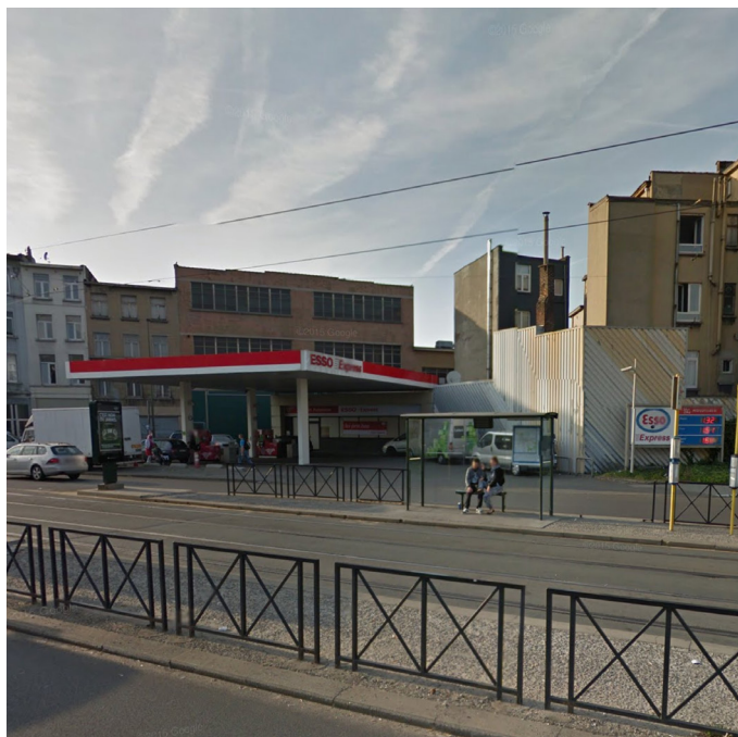
- foto van de bestaande toestand -
