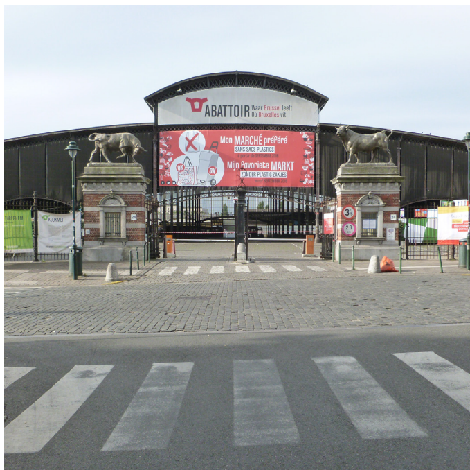
- foto van de bestaande toestand -
