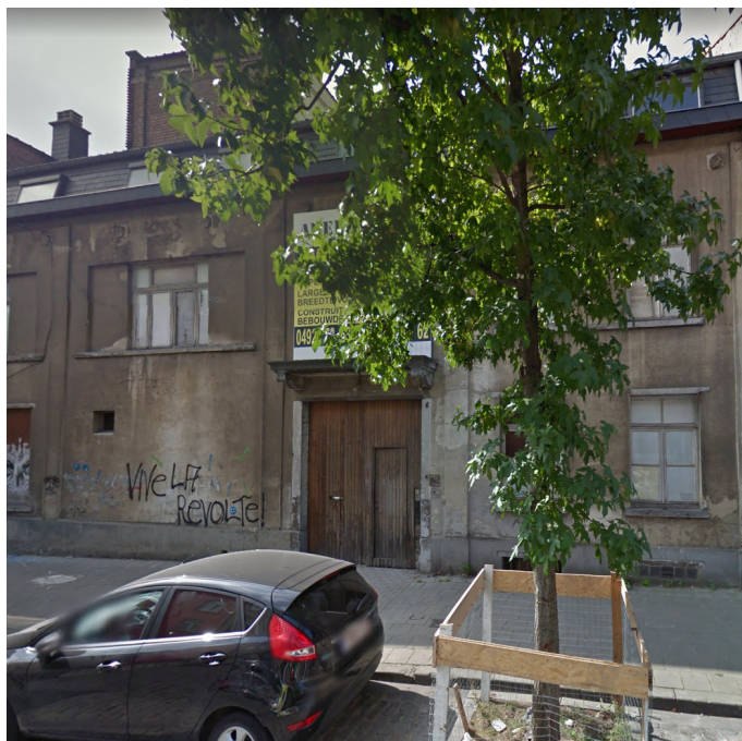
- foto van de bestaande toestand -
