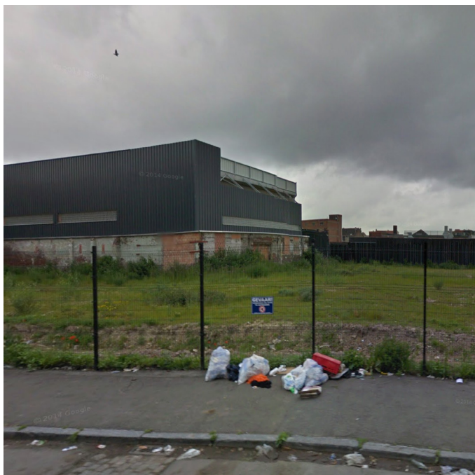
- foto van de bestaande toestand -
