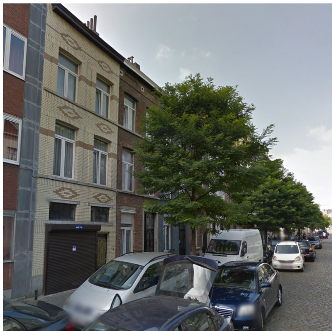
- foto van de bestaande toestand -
