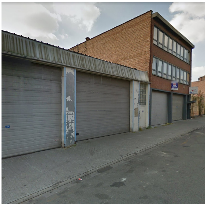
- foto van de bestaande toestand -
