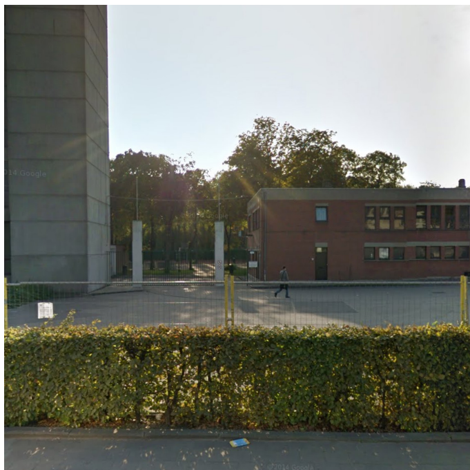
- foto van de bestaande toestand -
