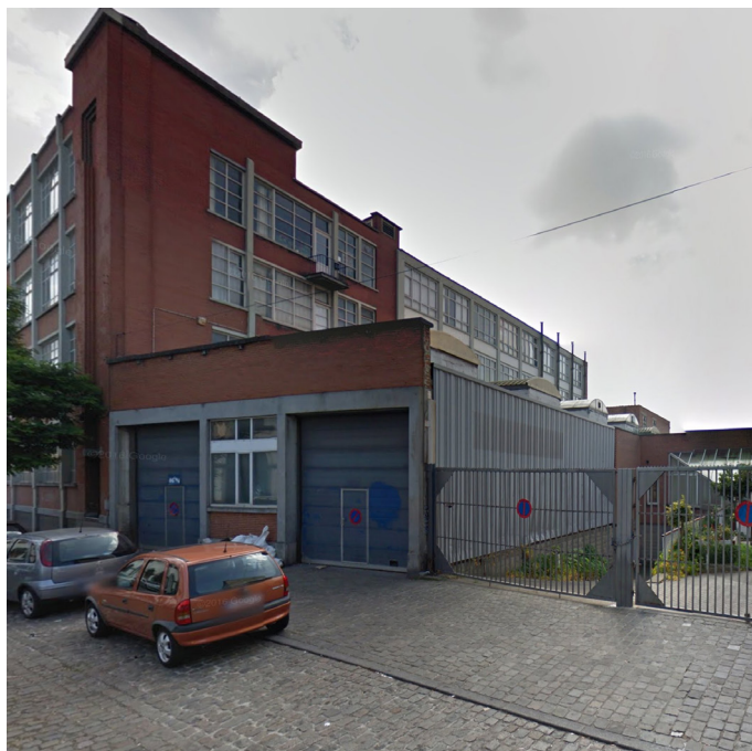
- foto van de bestaande toestand -
