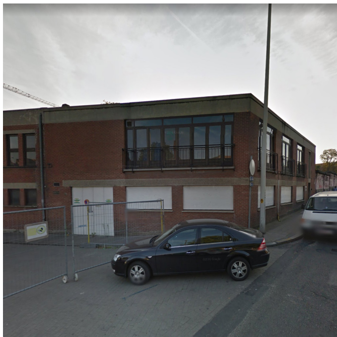
- foto van de bestaande toestand -
