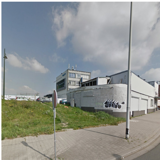
- foto van de bestaande toestand -
