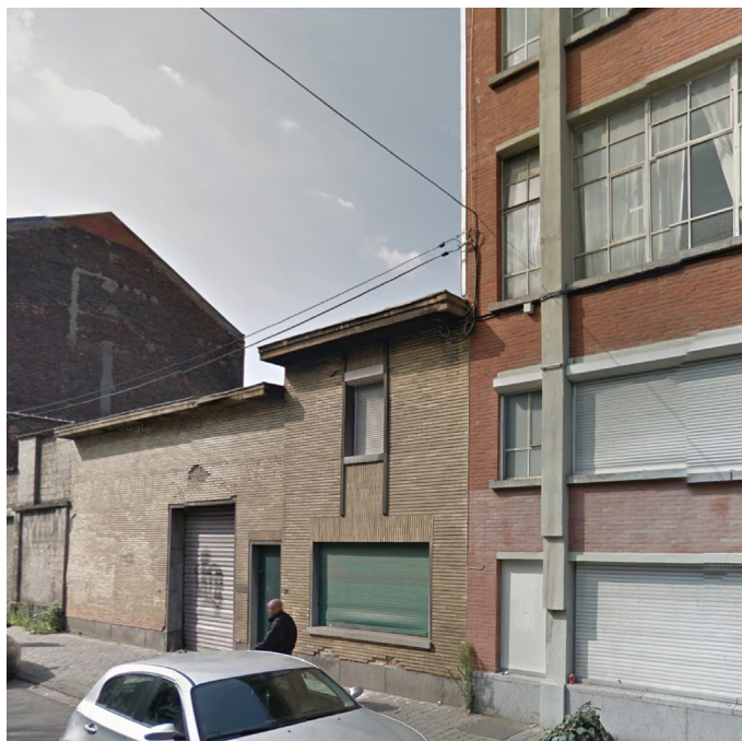
- foto van de bestaande toestand -
