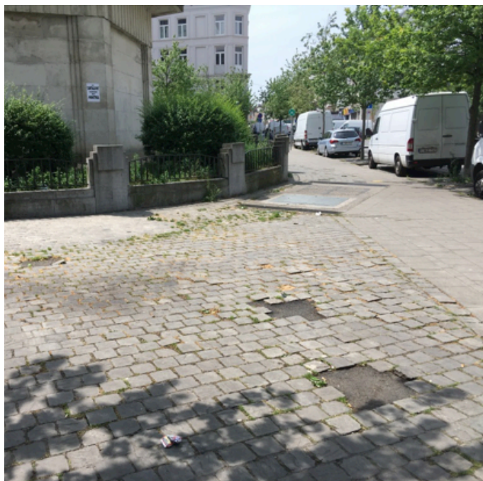
- foto van de bestaande toestand -
