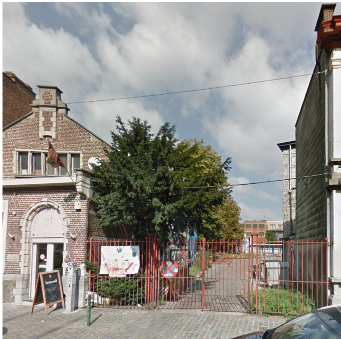
- foto van de bestaande toestand -
