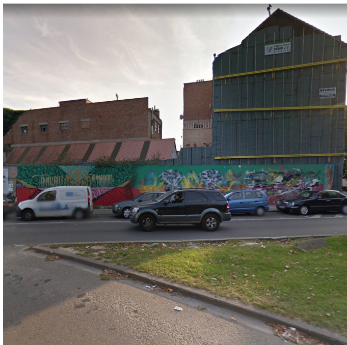
- foto van de bestaande toestand -
