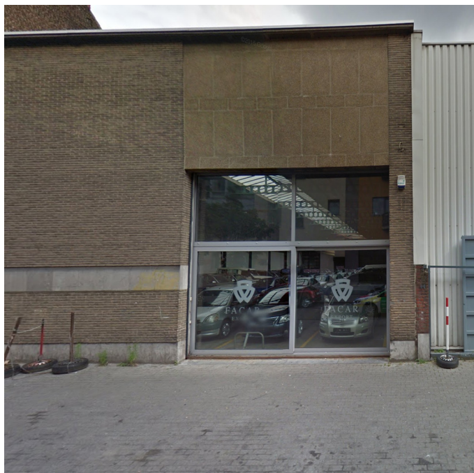
- foto van de bestaande toestand -
