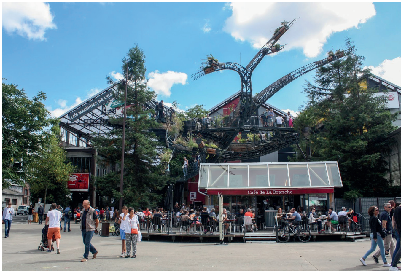
Référence: Ile de Nantes, galerie des machines
