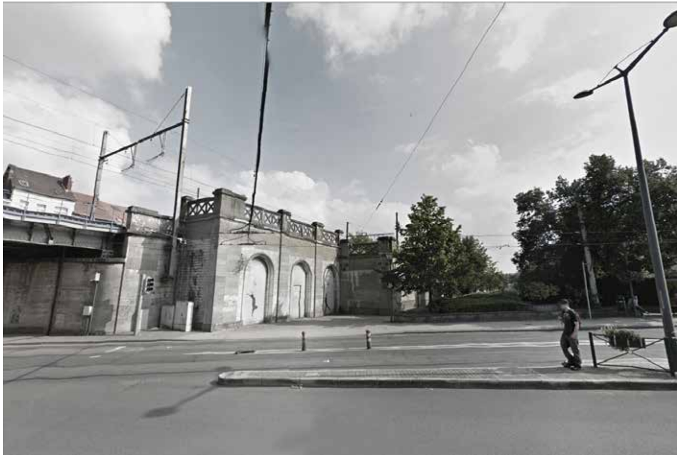
Bestaande situatie (Google View)
