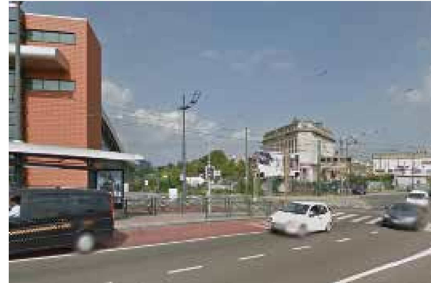
Bestaande situatie (Google View)
