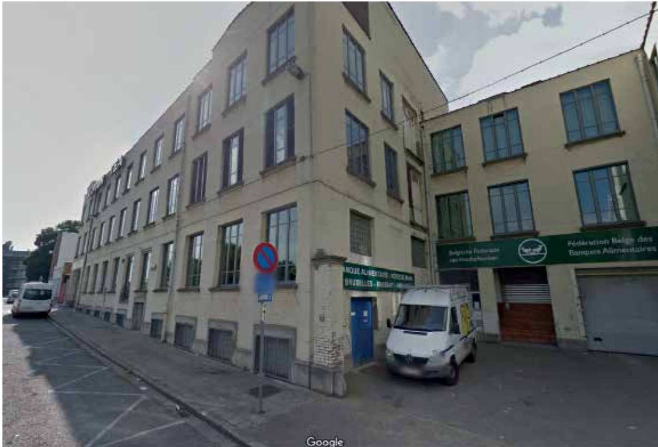
Bestaande situatie (Google View)
