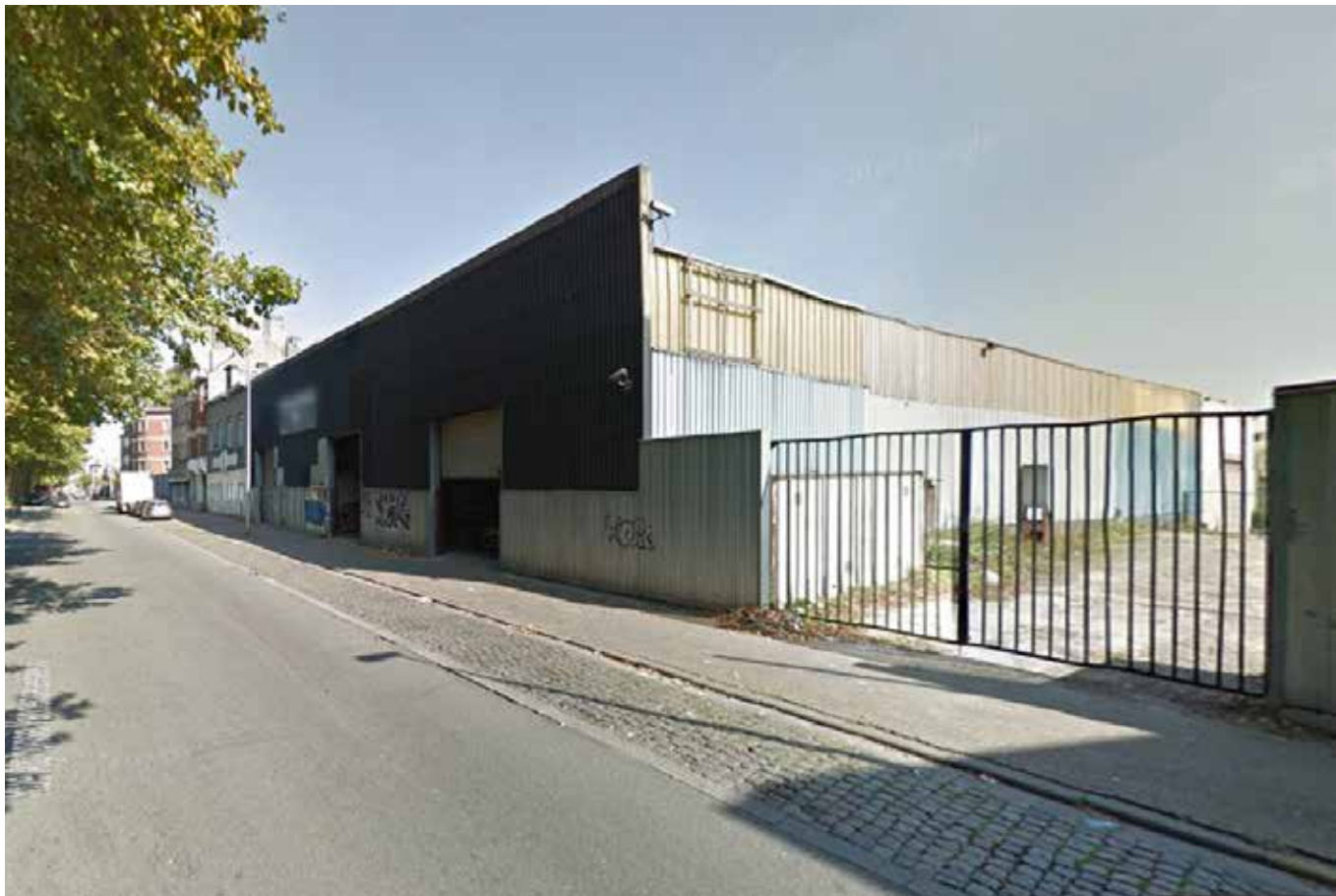
Bestaande situatie (Google View)
