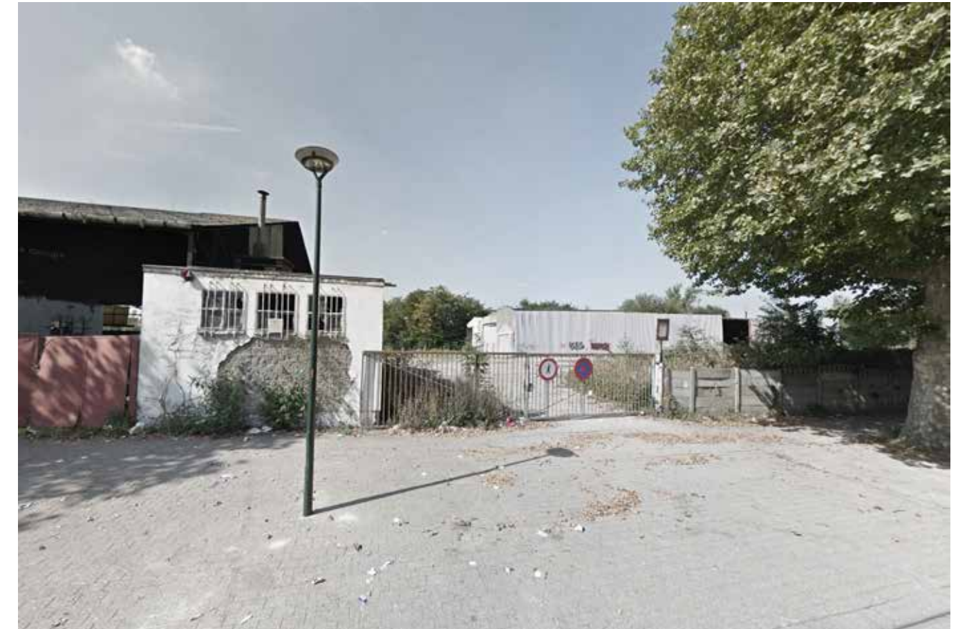
Bestaande situatie (Google View)
