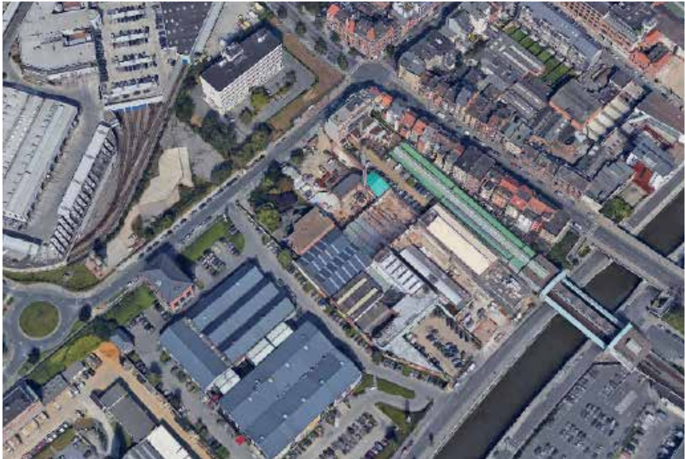
Bestaande situatie (Google View)
