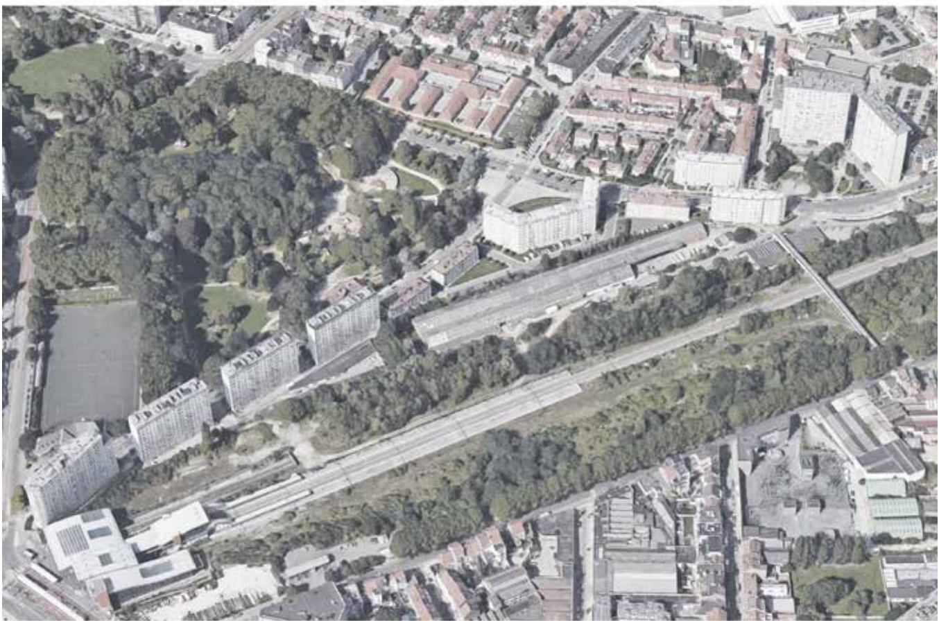
Bestaande situatie (Google View)
