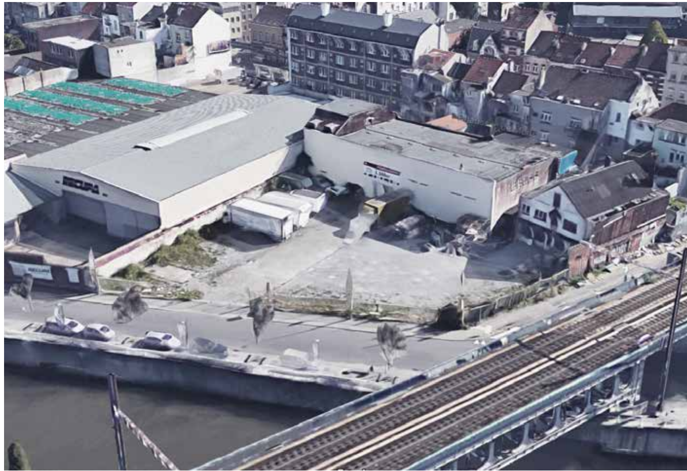
Bestaande situatie (Google View)
