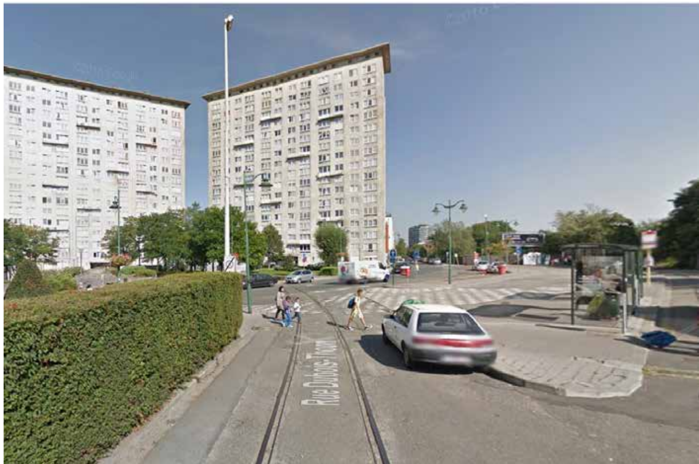
Bestaande situatie (Google View)
