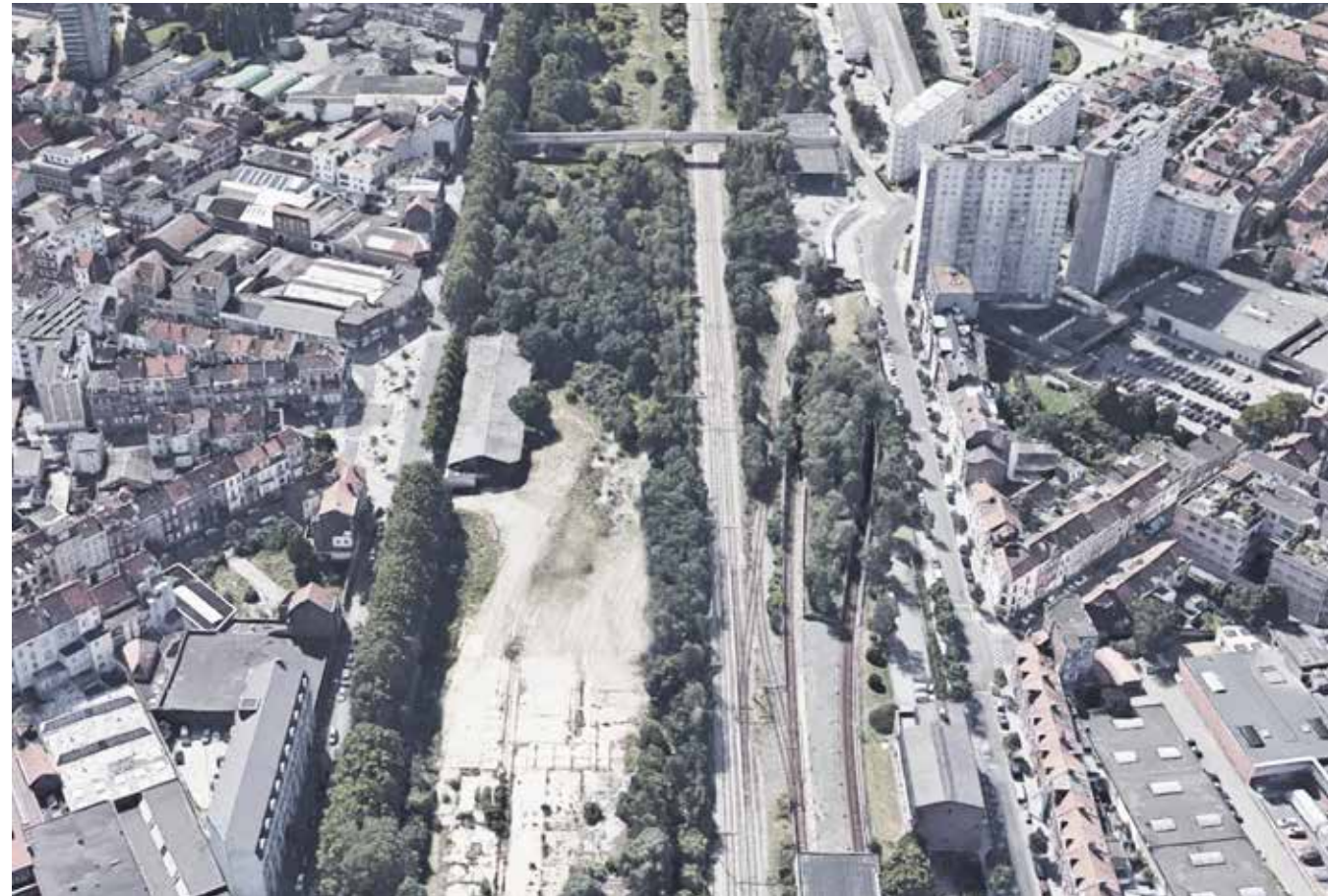
Bestaande situatie (Google View)
