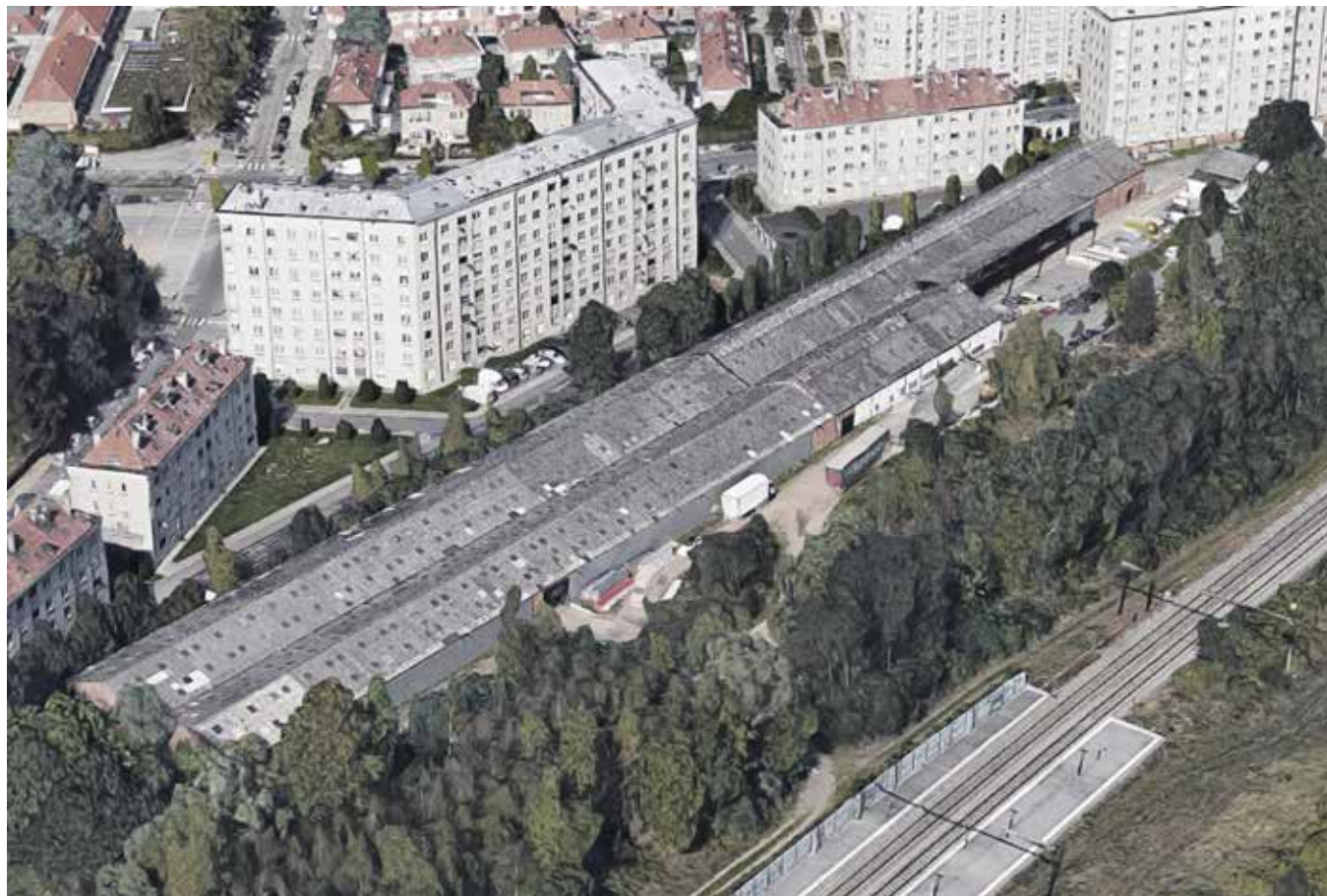
Bestaande situatie (Google View)
