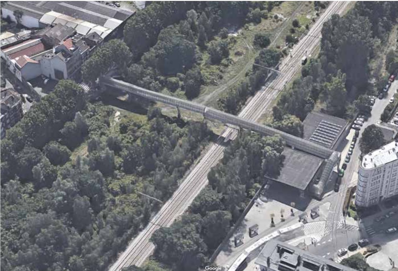
Bestaande situatie (Google View)
