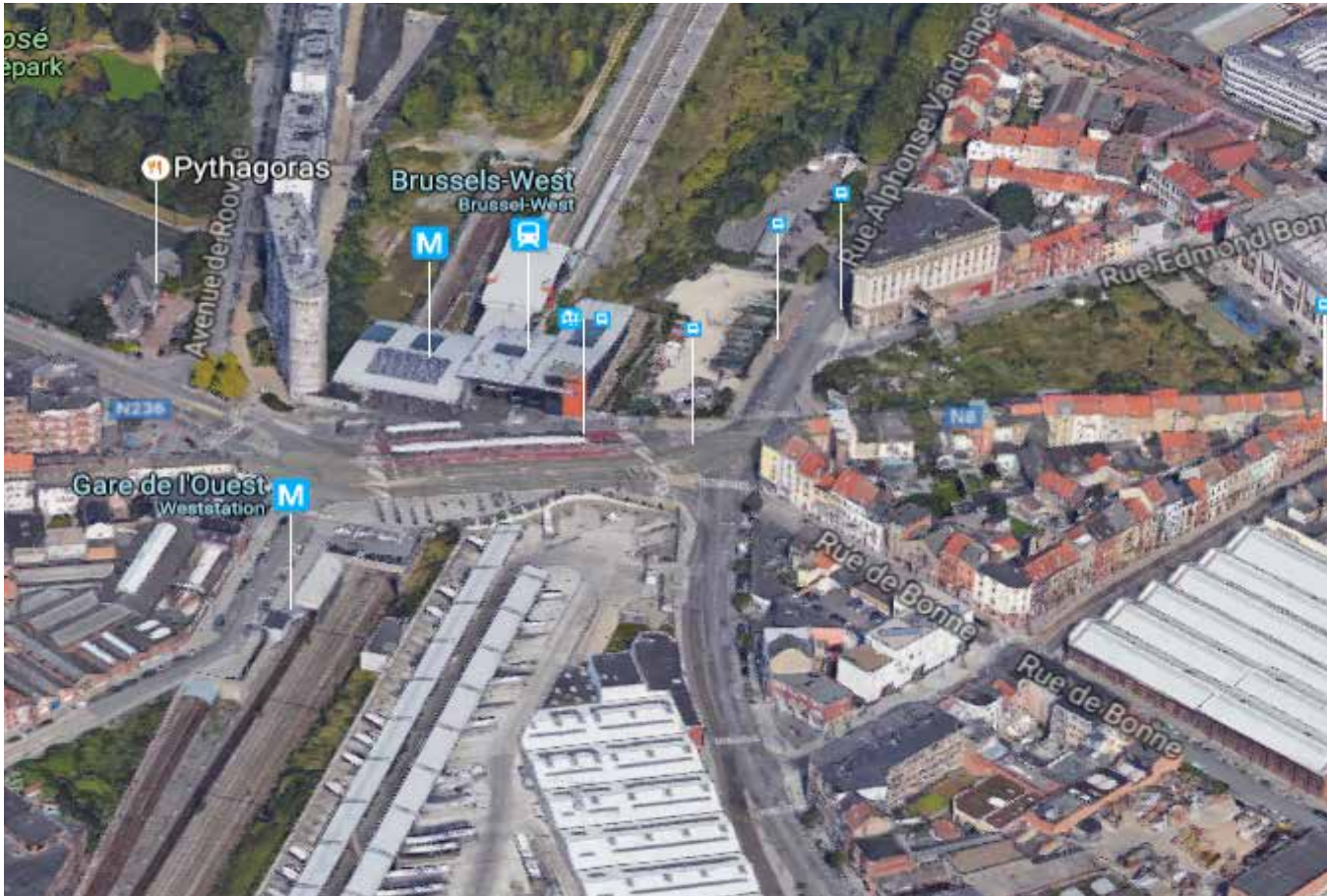
Bestaande situatie (Google View)
