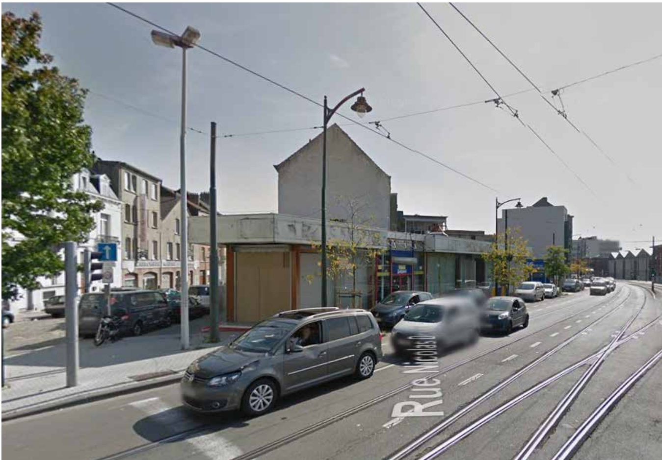
Bestaande situatie (Google View)
