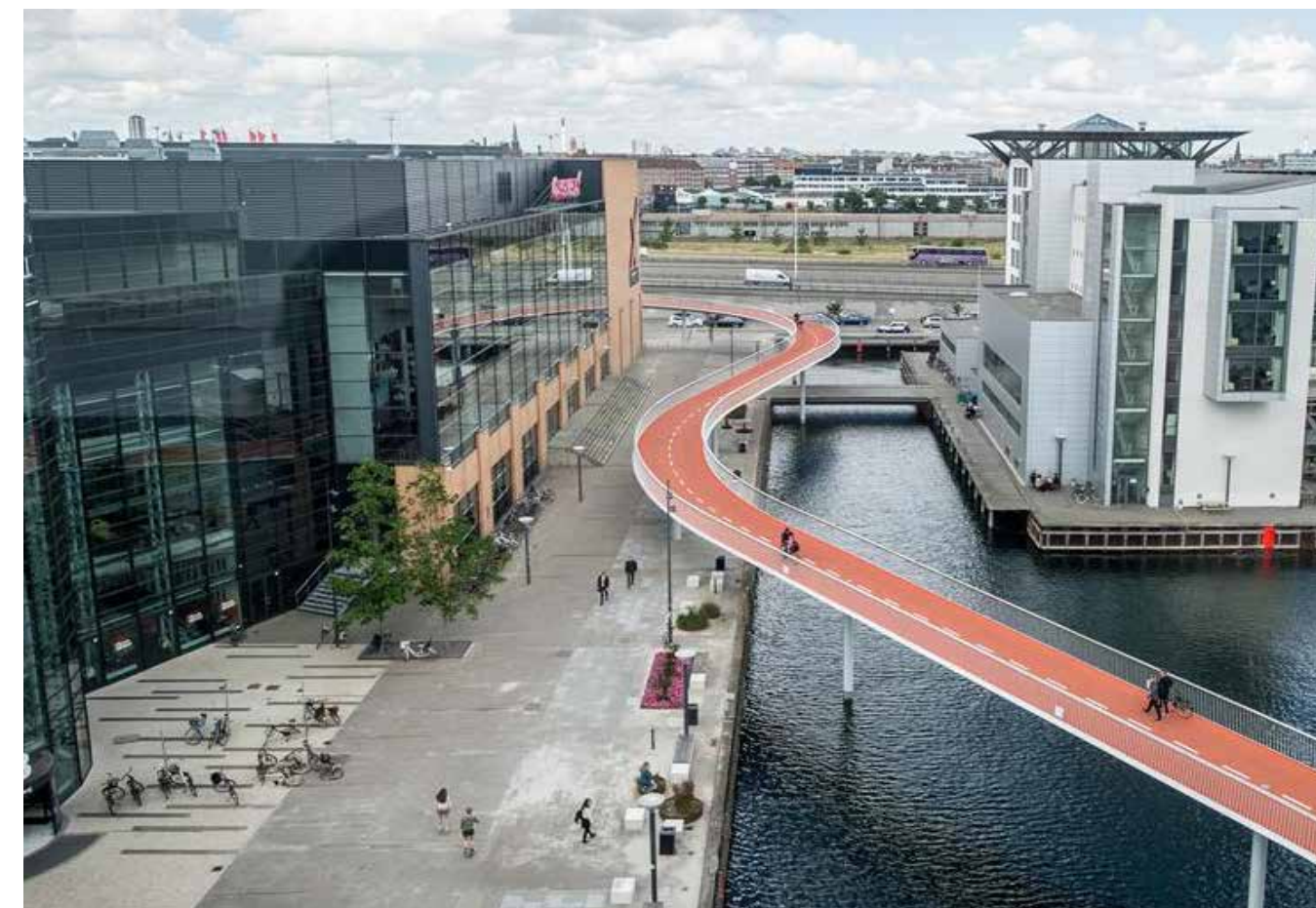
Référence: Pont cyclo-pieton 'Serpent' par DISSING + WEITLING, Copenhague
