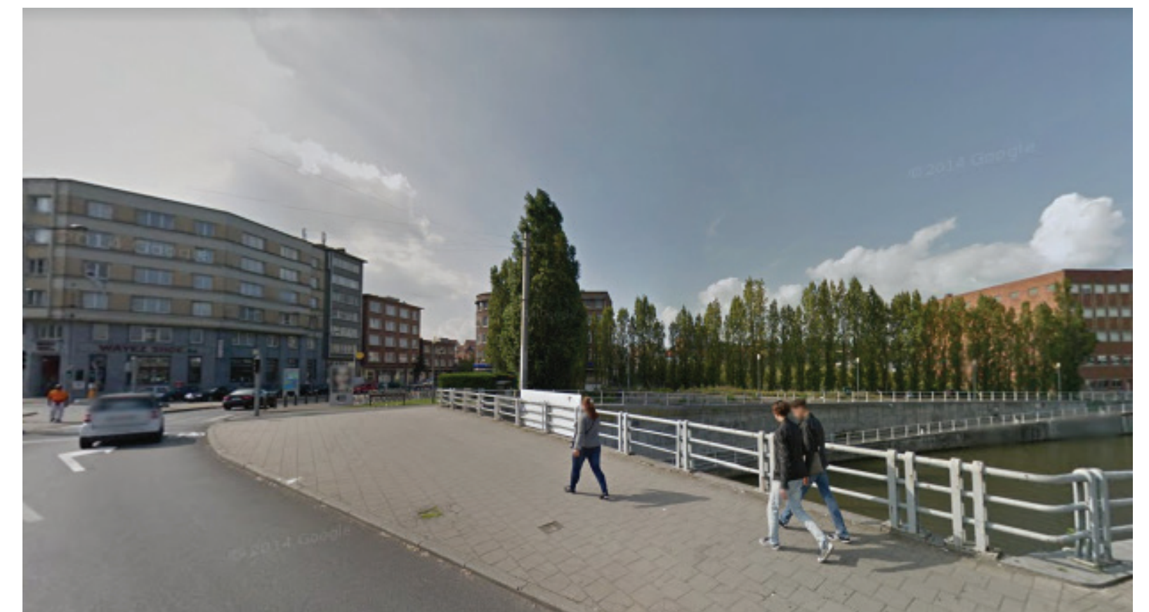
Situation actuelle / bestaande situatie
