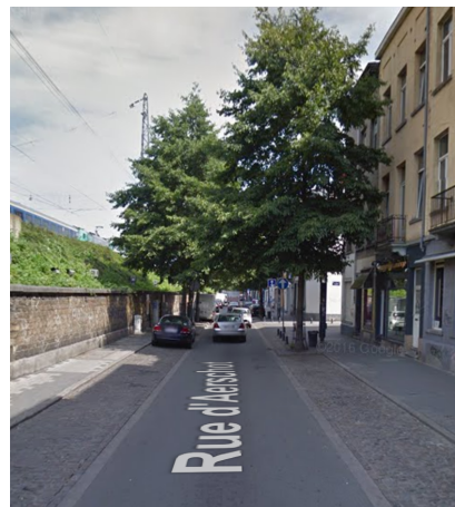
Relation du talus avec le cadre bâti environnant, rue d'Aerschot © GoogleStreetView
