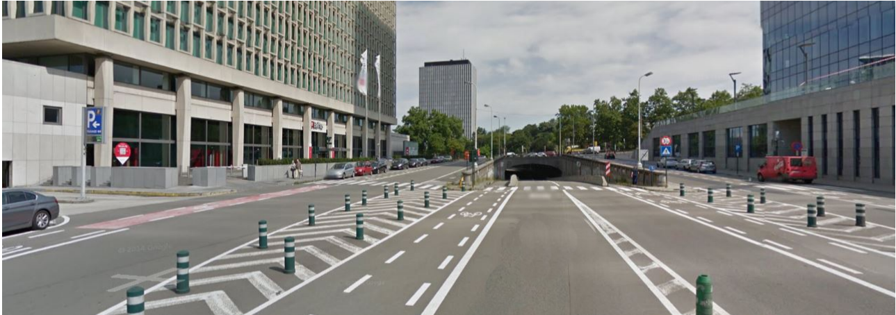
Espace encombré - vue depuis le boulevard Pachéco © Google Maps
