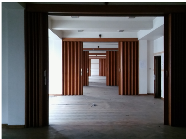
Espace modulable aux étages du bâtiment © ERU
