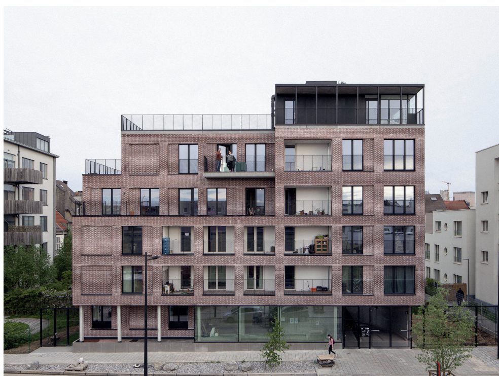
Logements solidaires d'habitat groupé - Tivoli - EPOC arch.
