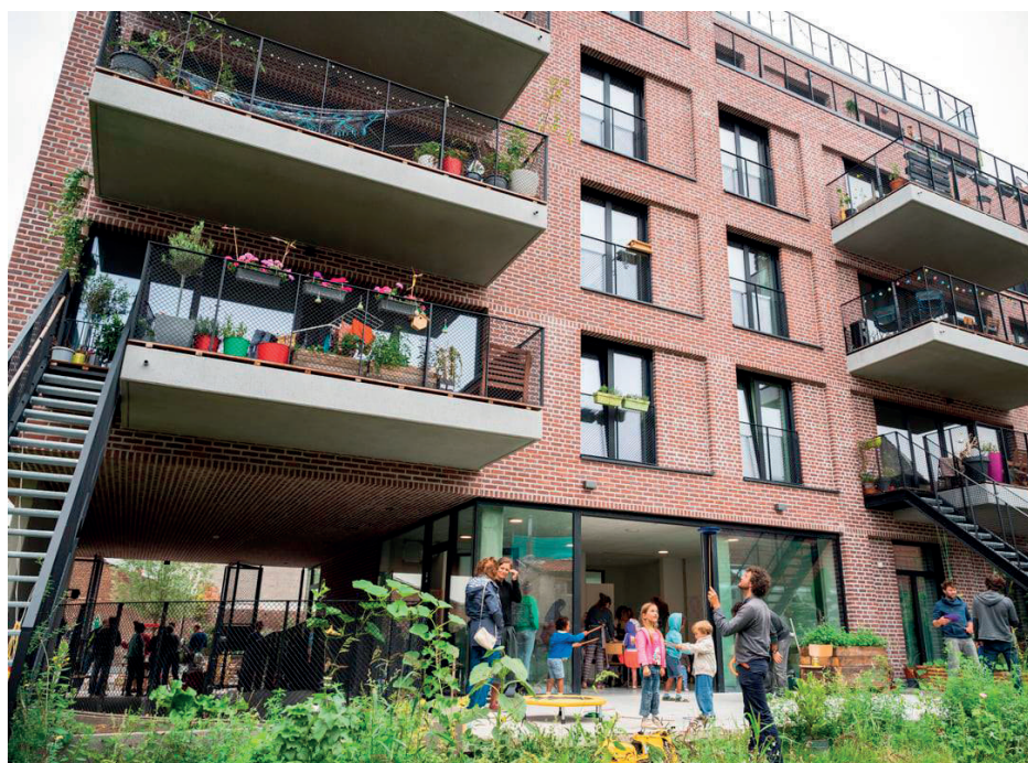
Espace commun - Logements solidaires d'habitat groupé - Tivoli - EPOC arch.
