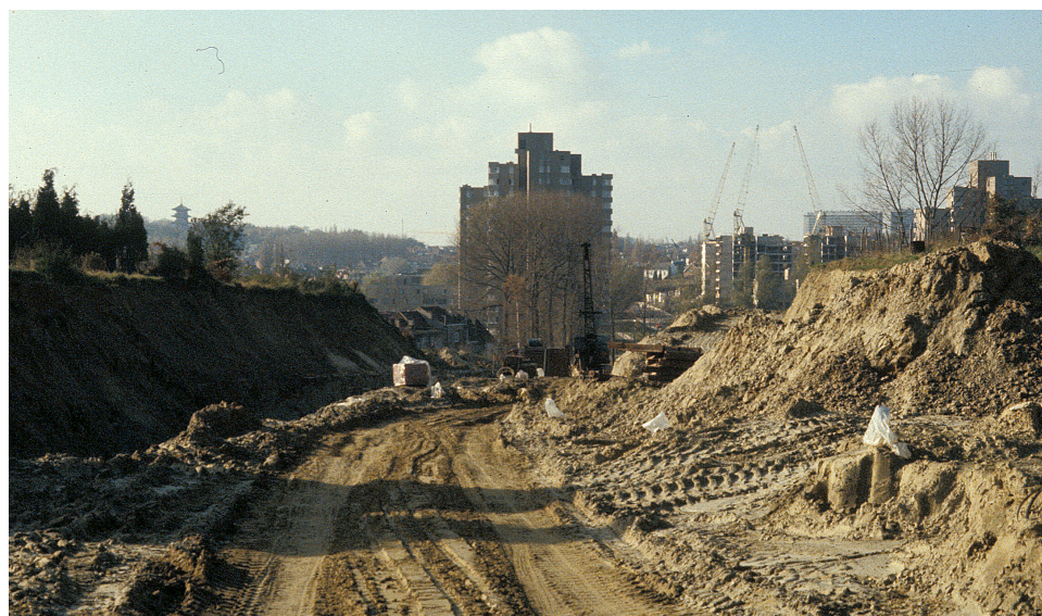
Construction de la rue du Craetveld. (3)
