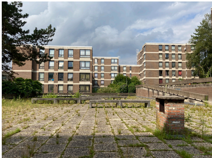
1. Bâtiments de logement de type phase 1 et 2 - Blocs d'appartements 1. Woongebouwen type fase 1 en 2 - Appartementsblokken
