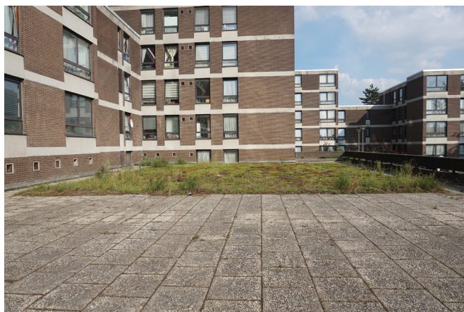
Les dalles de parking sur la rue de Beyseghem De betonnen platen in de Beizegemstraat
