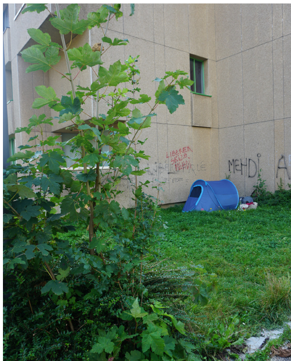
Espace moyennement dégradé - Rez de chaussée d'une tour Matig vervallen ruimte - Begane grond van een woontoren
