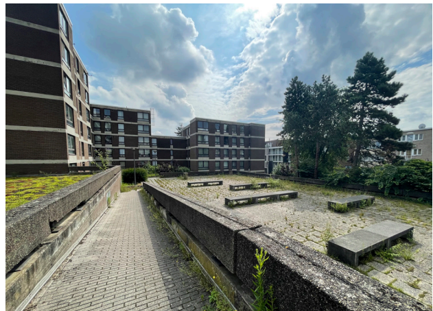
La dalle de la phase 1 Het parkeergaragedak van fase 1
