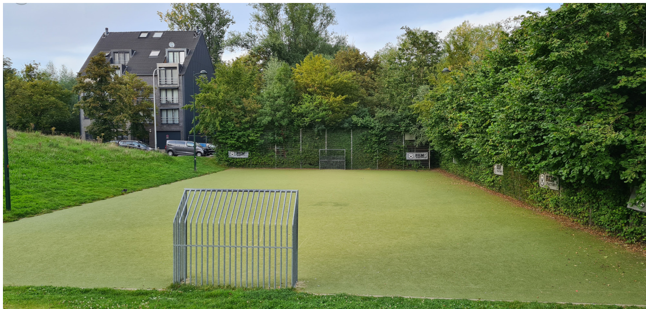
Le terrain de foot dont le revêtement de sol demande rénovation. Het voetbalveld, waarvan het vloeroppervlak gerenoveerd moet worden.
