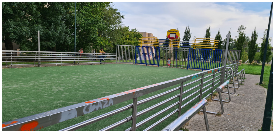
L'agora space / terrain de basket dont le revêtement de sol demande rénovation.
