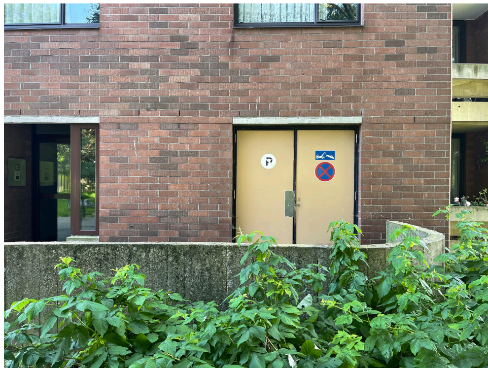
Salle poubelle et stockage au pied de bâtiment et à côté du hall d'entrée
