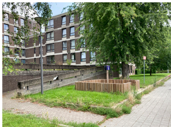
Espace moyennement dégradé - Rue de Beyseghem Matig vervallen ruimte - Beizegemstraat
