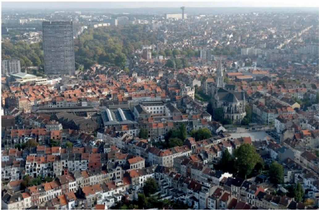
vue aeriene / luchtbeeld
