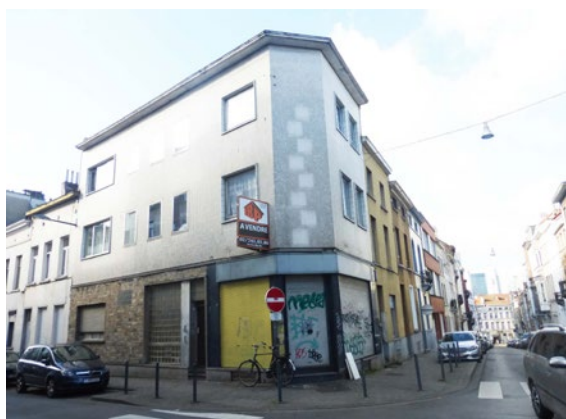
Rue de la Poste/ Poststraat 189-195
