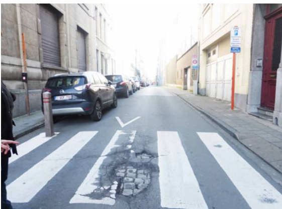
rue du Secours / Hulpstraat
