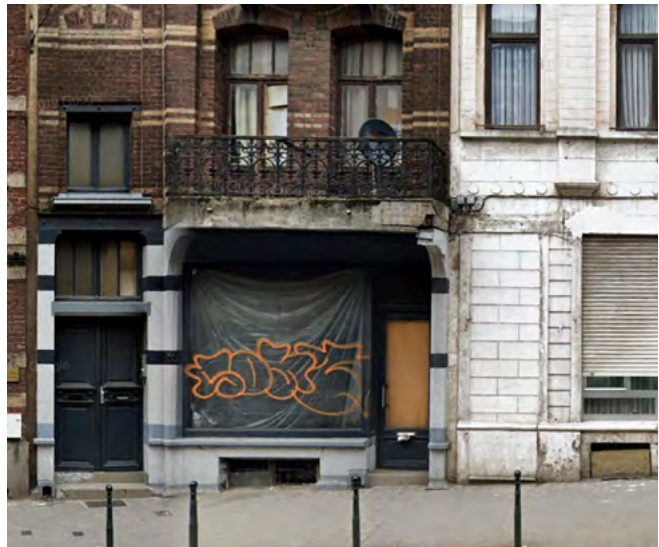
FIG. 33 Reeks woningen in slechte staat binnen de perimeter van het DWC Credits: © CityTools, Maart 2020
