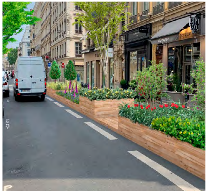
FIG. 20 Beplanting van een deel van de openbare weg - Lyon Credits: © Ville de Lyon
