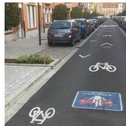
1_ Rue Sneessens/Baucq, Etterbeek Sneessensstraat / Baucqstraat, Etterbeek
