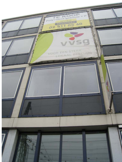
Immeuble de bureaux rue du Pavillon . Kantoorgebouw Paviljoenstraat
