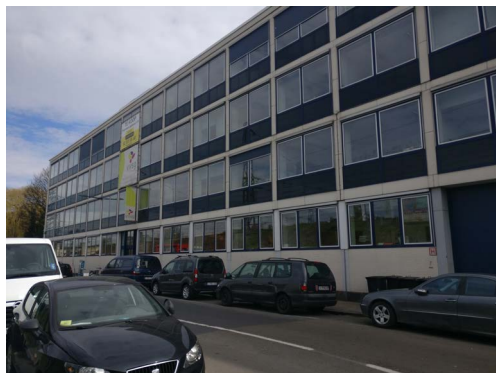
Immeuble de bureaux rue du Pavillon . Kantoorgebouw Paviljoenstraat
