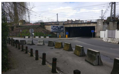
Vue sur le tunnel rue du Pavillon . Zicht op de Paviljoenstraattunnel
