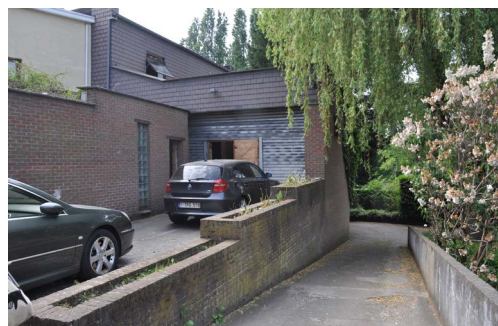
Rampe d'accès vers les bangars . Toegang inrit naar de bangars
