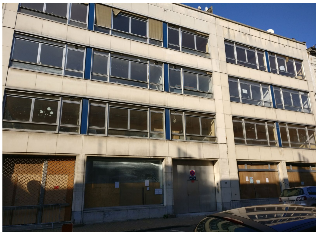
Illustration: La nouvelle mosquée Koubaa en chantier.
