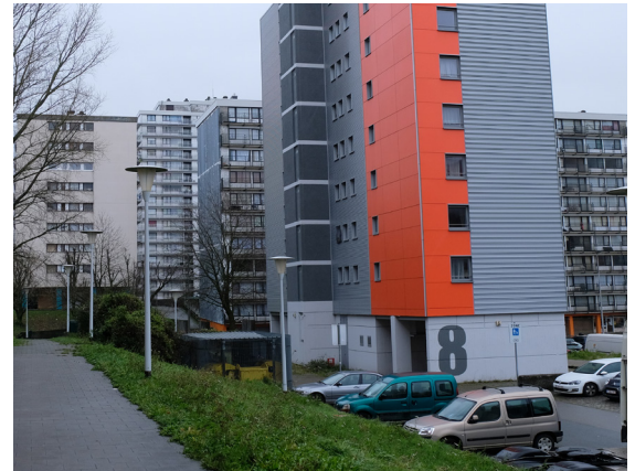
Gelijkvloers van Blok 8 westgevel
