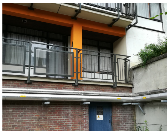
gelijkvloers blok 9 oostelijke gevel (kant voorzieningen)
