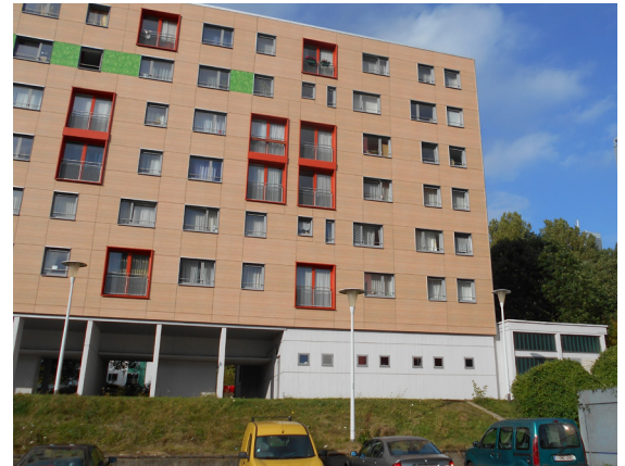
RDC Bloc 6 façade Sud
