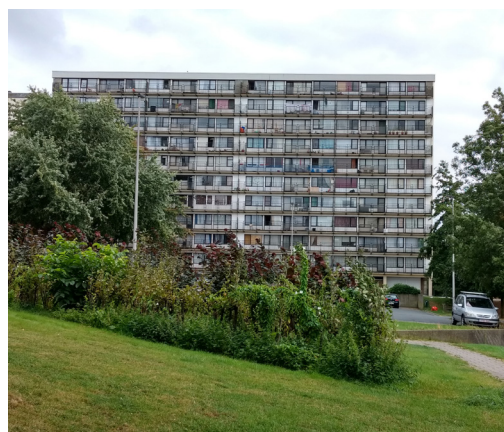
Bloc 9 façade Ouest
