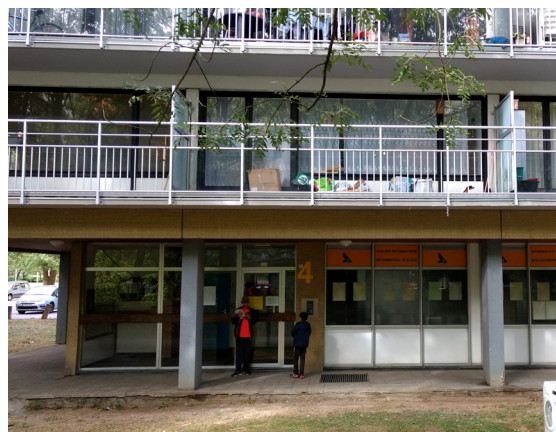
RDC Bloc 4 façade Sud
