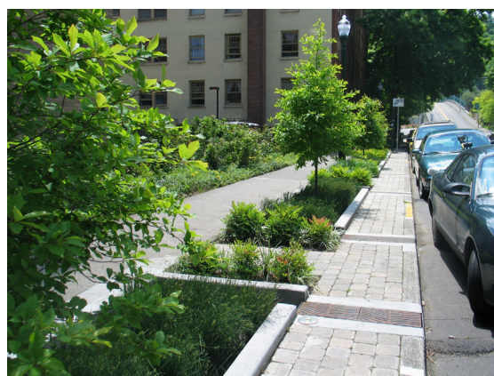
Noues des Green Streets - Portland, Oregó, USA
