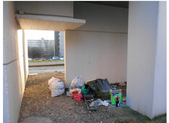
Espaces traversants au RDC du bloc 8
