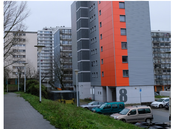
RDC Bloc 8 façade Ouest
