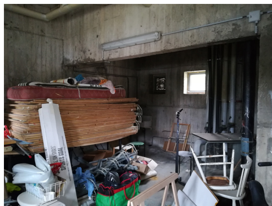
Intérieur du RDC Bloc 8
