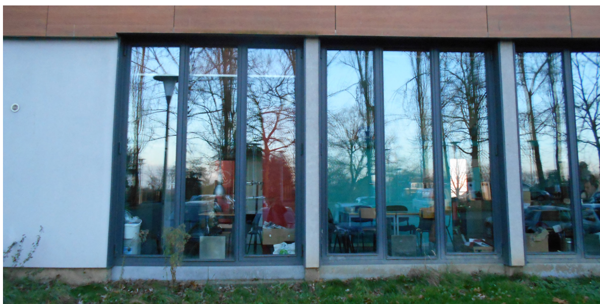
Locaux des associations au RDC du Bloc 3 Verenigingslokaal op het gelijkvloers van blok 3
