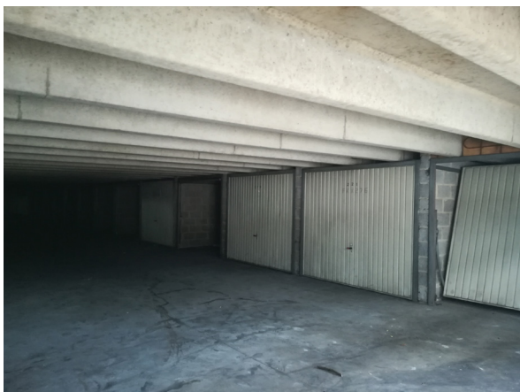
Parking couvert du Foyer Anderlechtois Overdekte parking van de Anderlechtse Haard
