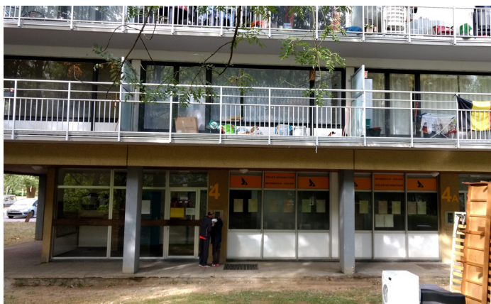
Local informatique au rez-de-chaussée du Bloc 4 | Computerlokaal op het gelijkvloers van blok 4
