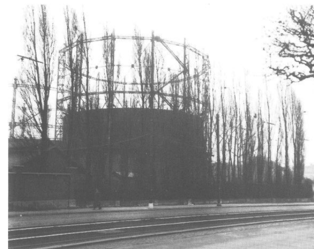
FOTO VAN EEN GASHOUDER TE ESSEGHEM bron: CHAF - Comté de Jette - 1993/1994 Gazomètres ©
