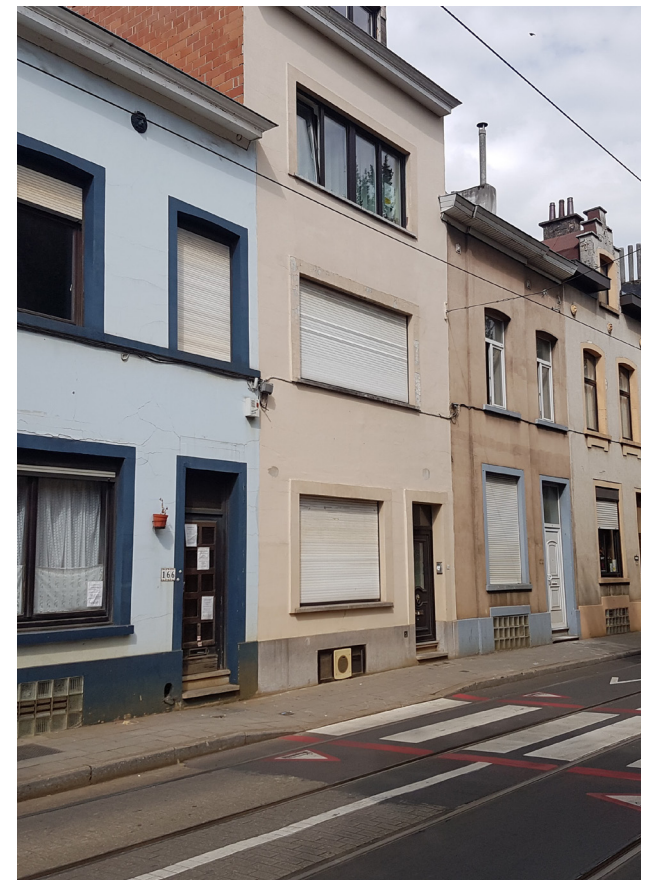
JULES LAHAYESTRAAT - te weinig geïsoleerde gevels bron: fotografie ARTER ©
