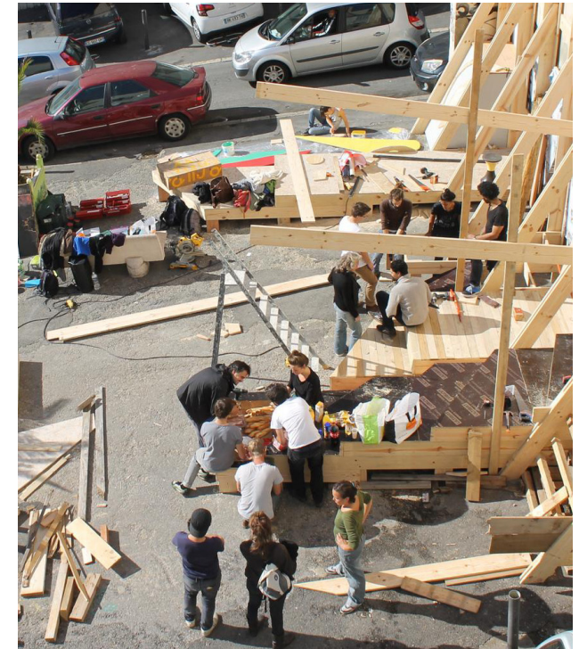
Chantier participatif - Collectif d'architectes ETC, Marseille source : collectifetc ©
