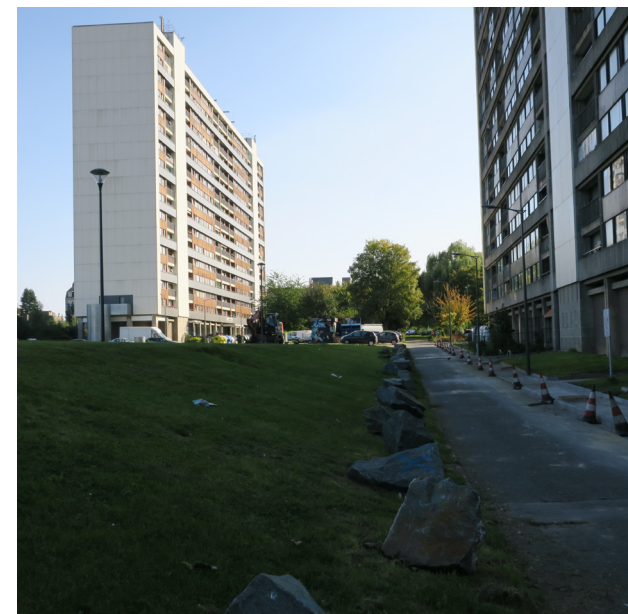
Gabarits élevés des tours 1 et 2 : site Essegheem source : photographie Arter ©
