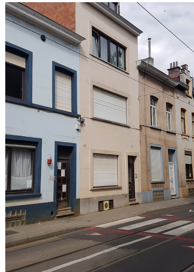
RUE JULES LAHAYE - façades peu isolées source : photographie ARTER ©
