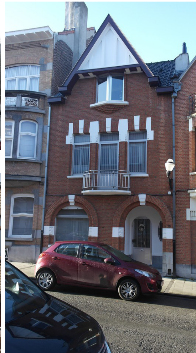
79, RUE DES AUGUSTINES source : photographie ARTER ©
