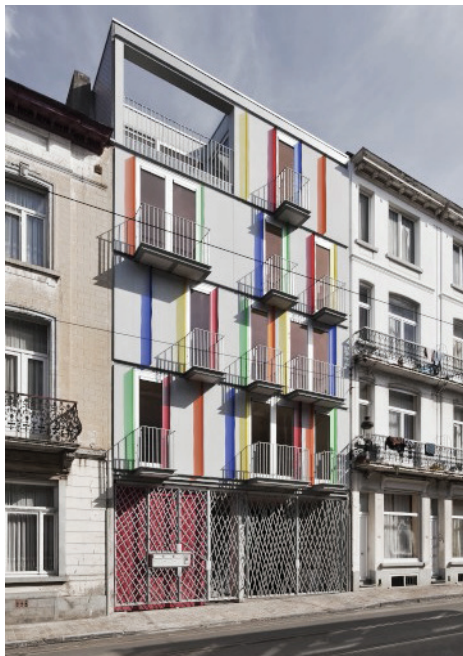
Sociale woningen Goossensstraat
