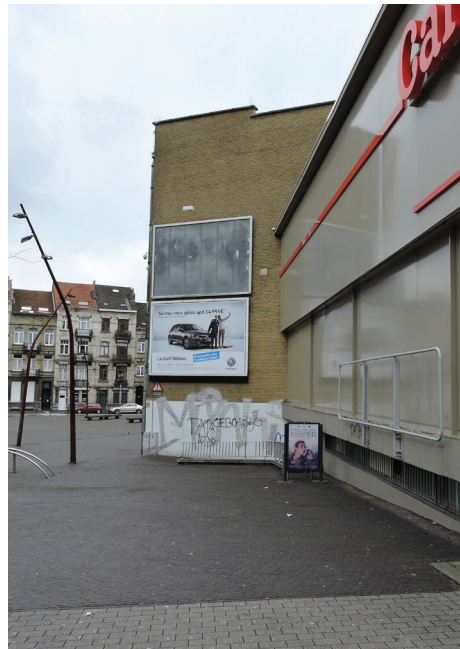
Carrefour - Jerusalemstraat GATEN IN HET BOUWFRONT
