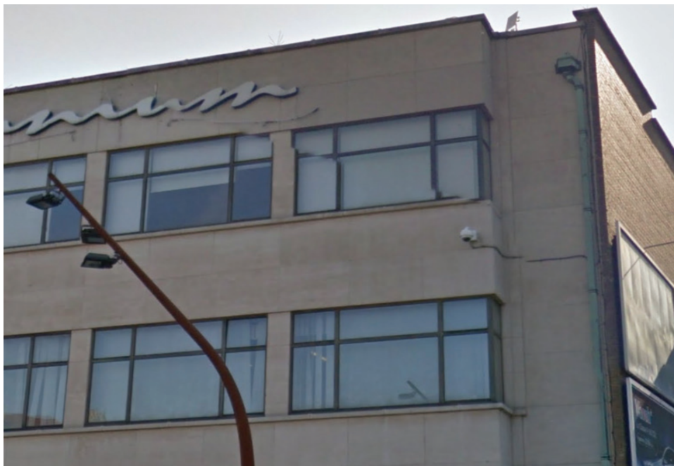
Deux cameras installées pour améliorer cette situation.
