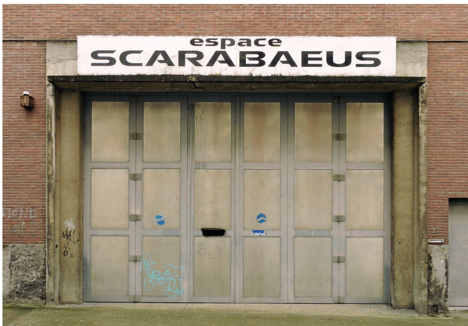
Le Scarabaeus et sa grande porte fermée vers la rue Creuse
