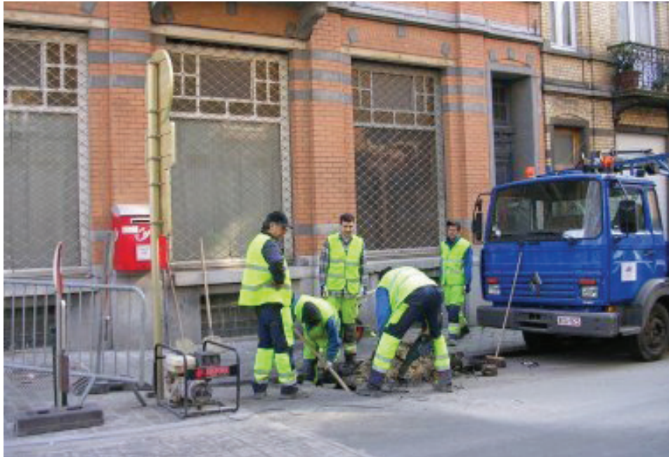
JST implique les jeunes schaerbekois pour des multiples travaux dans l'espace public
