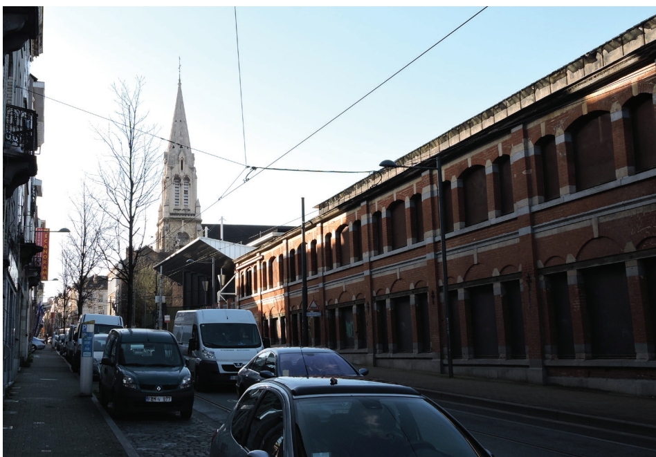
Dépôt STIB - chaussée de Haecht MURS AVEUGLES
