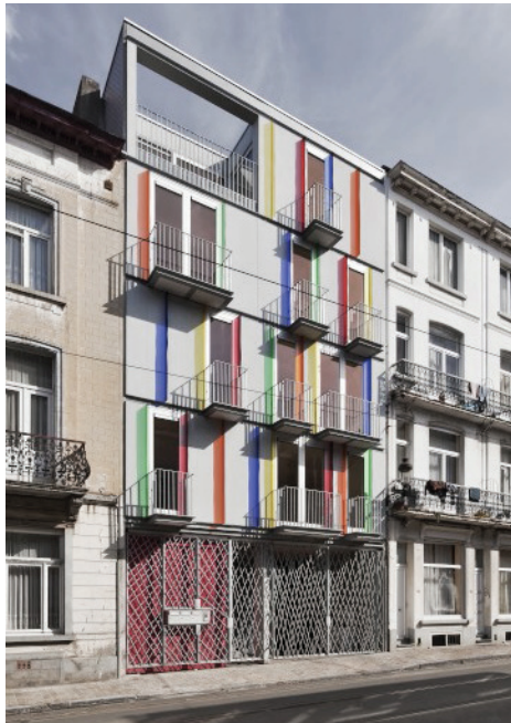
Logements sociaux rue Goossens
