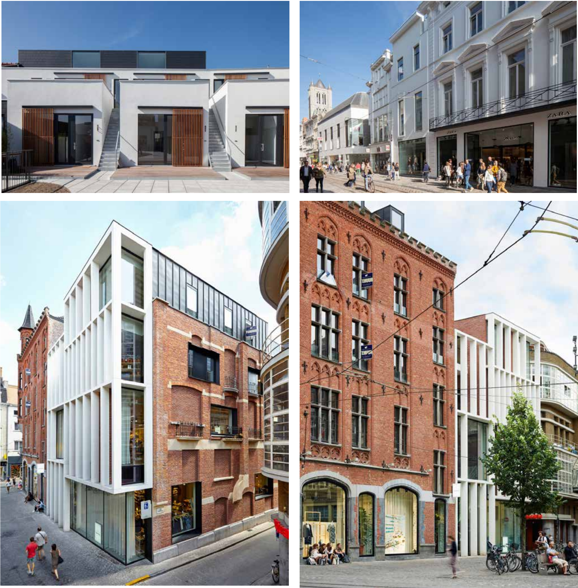
Logements au-dessus des commerces, Veldstraat Gand (Abscis) bron/source: http://www.abscis-architecten.be/nl/projecten/gemengd-woonproject-veldstraat-gent/333 bron/source: http://www.abscis-architecten.be/nl/projecten/verbouwing-van-een-historisch-pand-korenmarkt-gent/441
