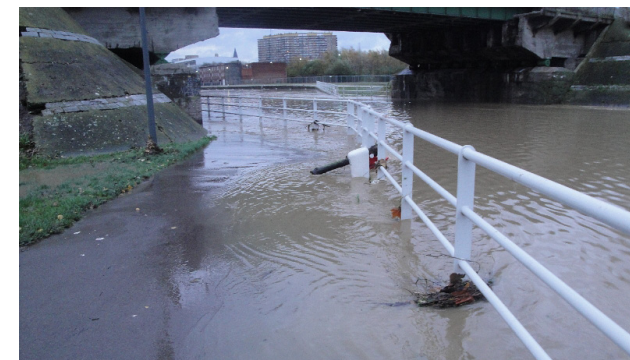
• Overstromingen in 2010 - Pierre Marchantbrug Bron: http://www.coordinationssenne.be/ ©
