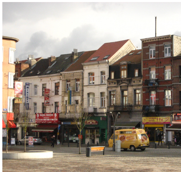
• Wayezstraat - gevel die uitkijkt op het Verzetplein, 90-104 Bron: foto Árter - april 2015 ©
