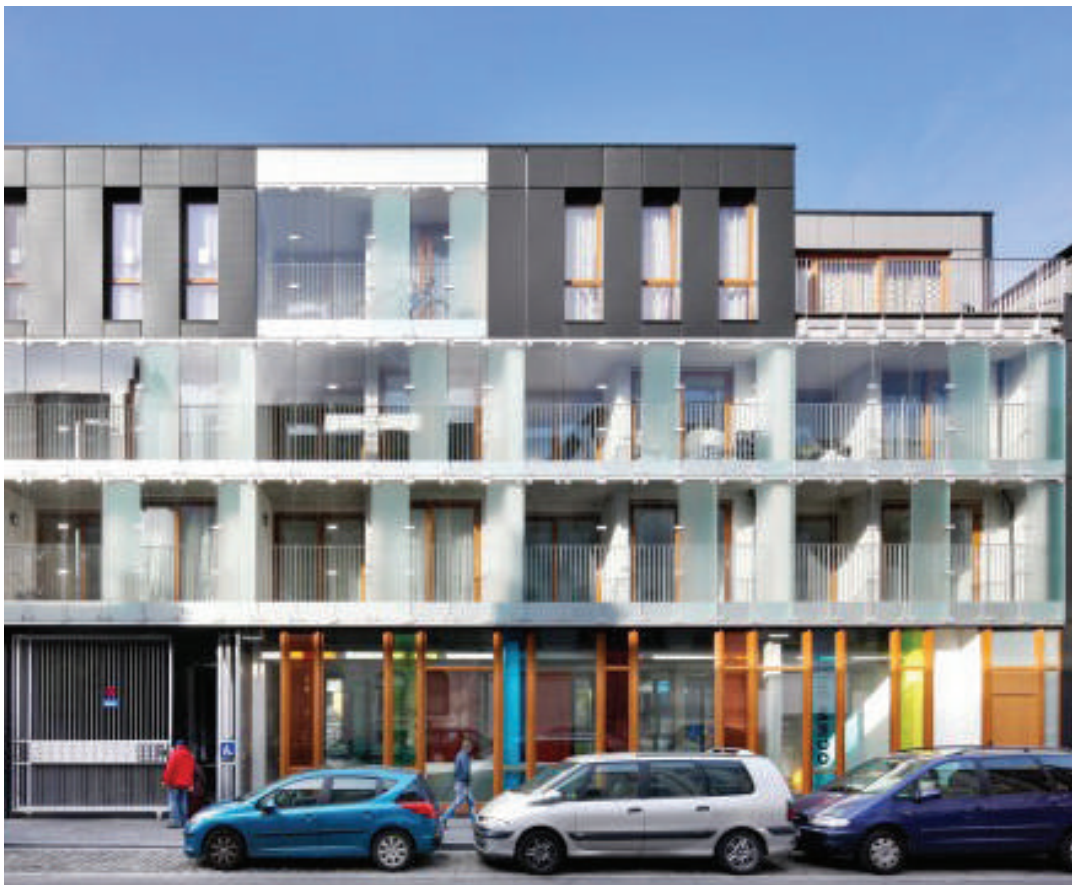
Creche Savonnerie Heymans (Anderlecht, België) | MDW Architecture
