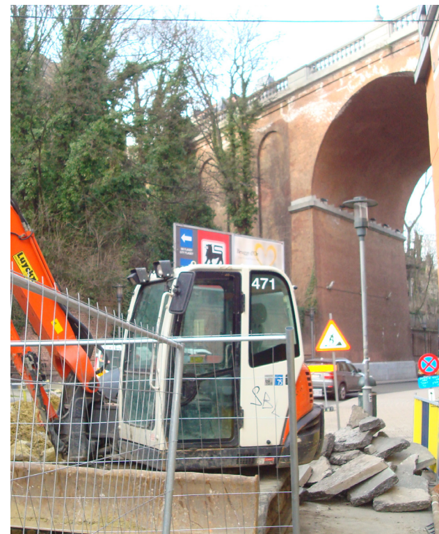
• Herstelingswerken aan de riolering in de Graystraat bron: foto Arter - maart 2013
