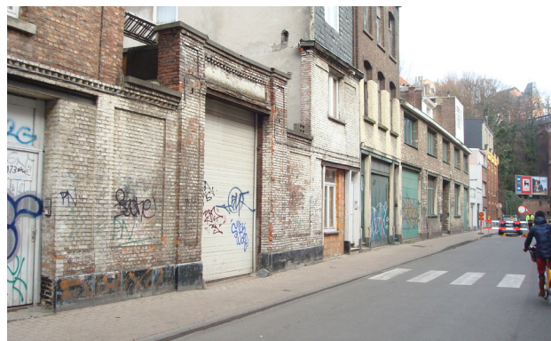
• Duidelijk bouwvallige staat van de bebouwing ter hoogte van Graystraat 167-173 bron: foto Ártar - april 2013
