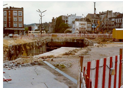
Werkzaamheden aanleg metro Bockstael E. Bockstaelplein, Brussel 1979
