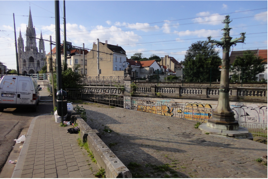
07. Passage Chambon Chambon doorgang
