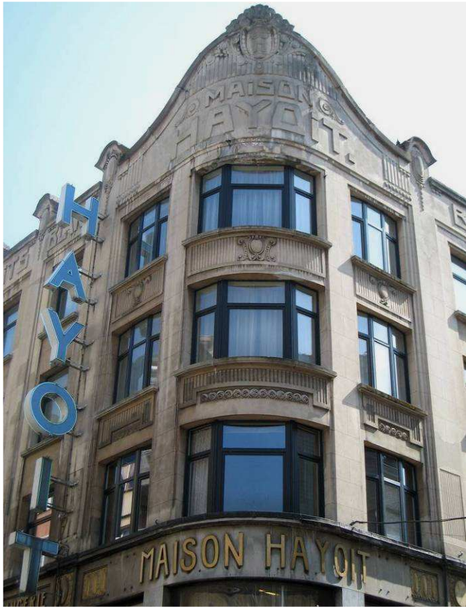
Maison Hayoit, 35/37 chaussée de Louvain/ rue du Vallon, 1927
