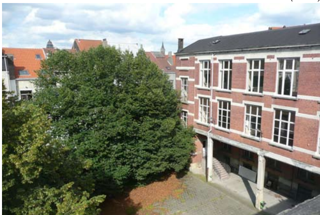
^ Intérieur d'îlot - bâtiment F - cour (2012)
