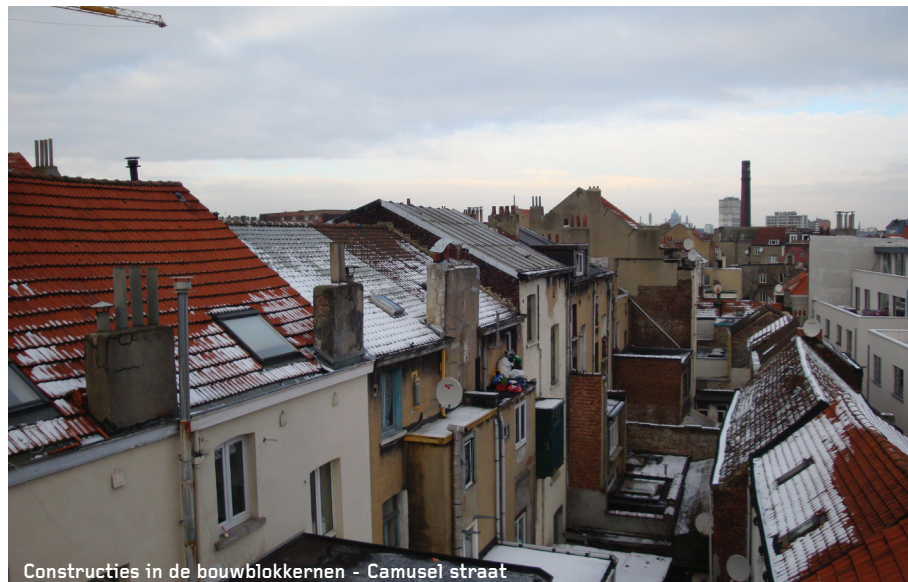
Constructies in de bouwblokkernen - Camusel straat
