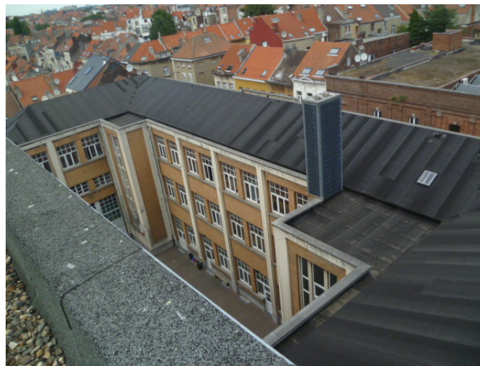
Afbeelding 14: Zicht op het dak van de Henri Frick-school.
