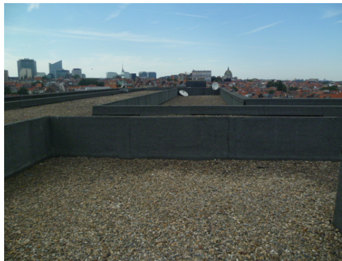
Afbeelding 13: Zicht op het dak van het Lycée Guy Cudell.
