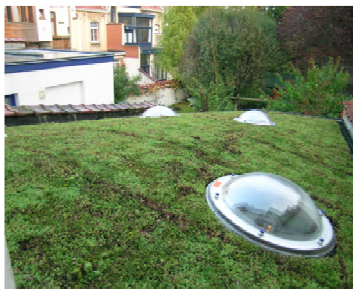
Voorbeeld van een groene dak Zien: www.brusselsgreentech.be
