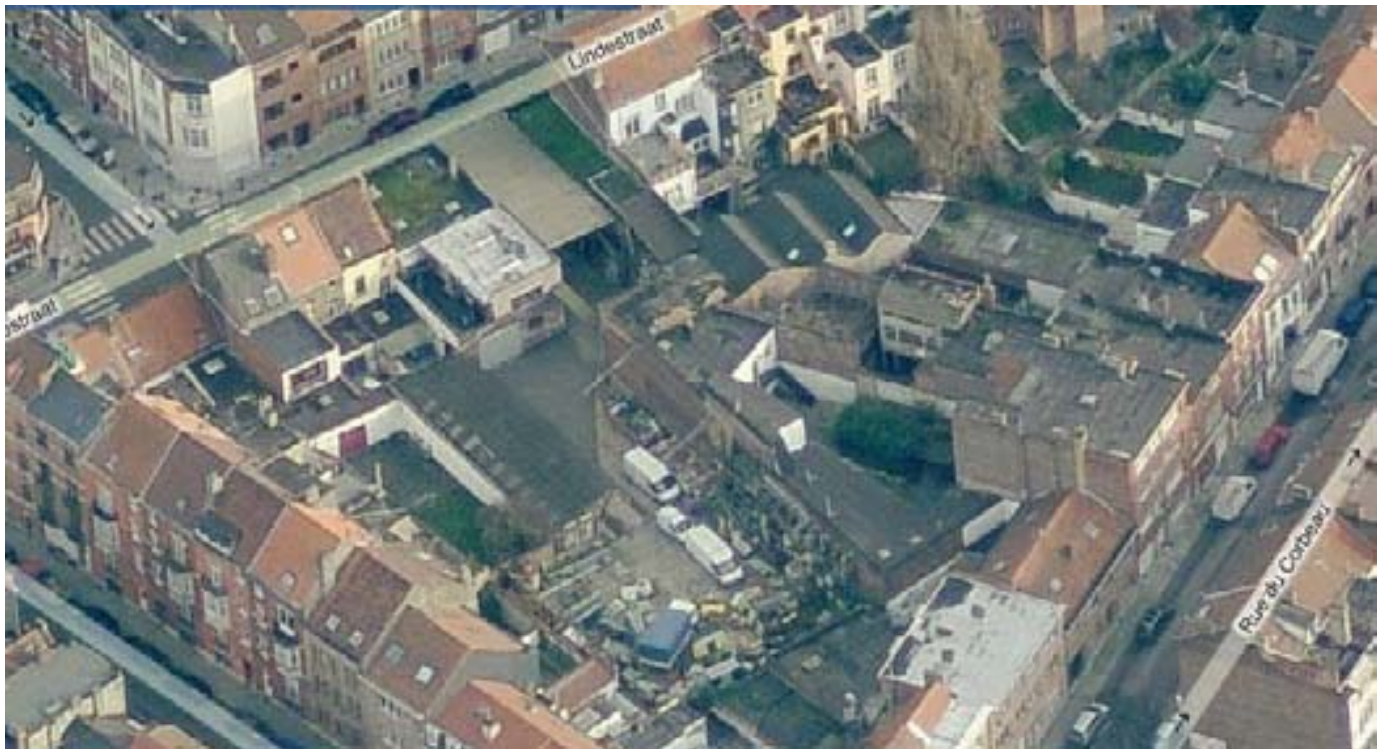
Intérieur d'îlot: entreprises
