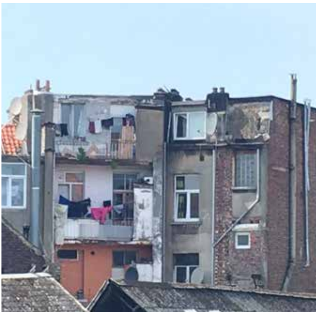
Photos des façades arrières. Foto's van de achtergevels.
