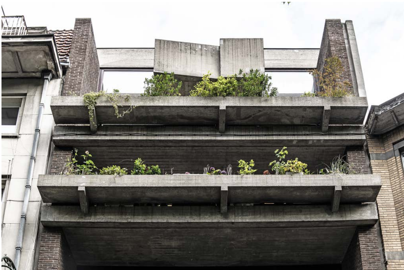
Kantoor en appartement van de architect Paul Caulier, Landsroemlaan 10, Koekelberg. A. de Ville de Goyet © urban.brussels
