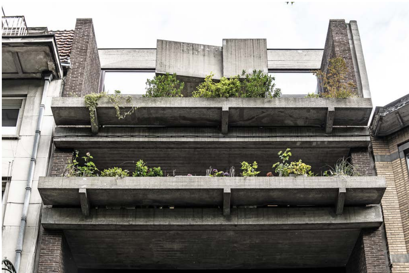
Bureau et appartement de l'architecte Paul Caulier, avenue des Gloires Nationales 10, Koekelberg. A. de Ville de Goyet © urban.brussels
