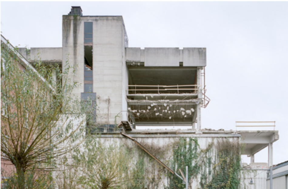
DWC “Wiels aan de Zenne” in Vorst, werf voor de herinrichting van het gebouw aan de Belgradostraat 74 tot sociale woningen en polyvalente zaal door &bogdan, foto 2024. Séverin Malaud © urban.brussels
