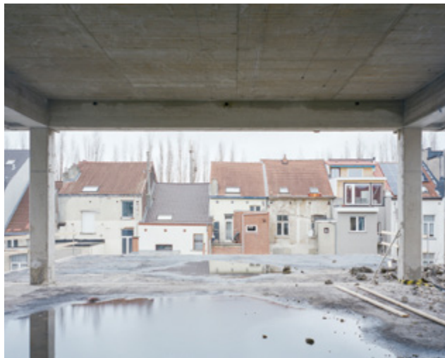
DWC "Wiels aan de Zenne" in Vorst, werf voor de herinrichting van het gebouw aan de Belgradostraat 74 tot sociale woningen en polyvalente zaal door &bogdan, foto 2024. Séverin Malaud © urban.brussels
