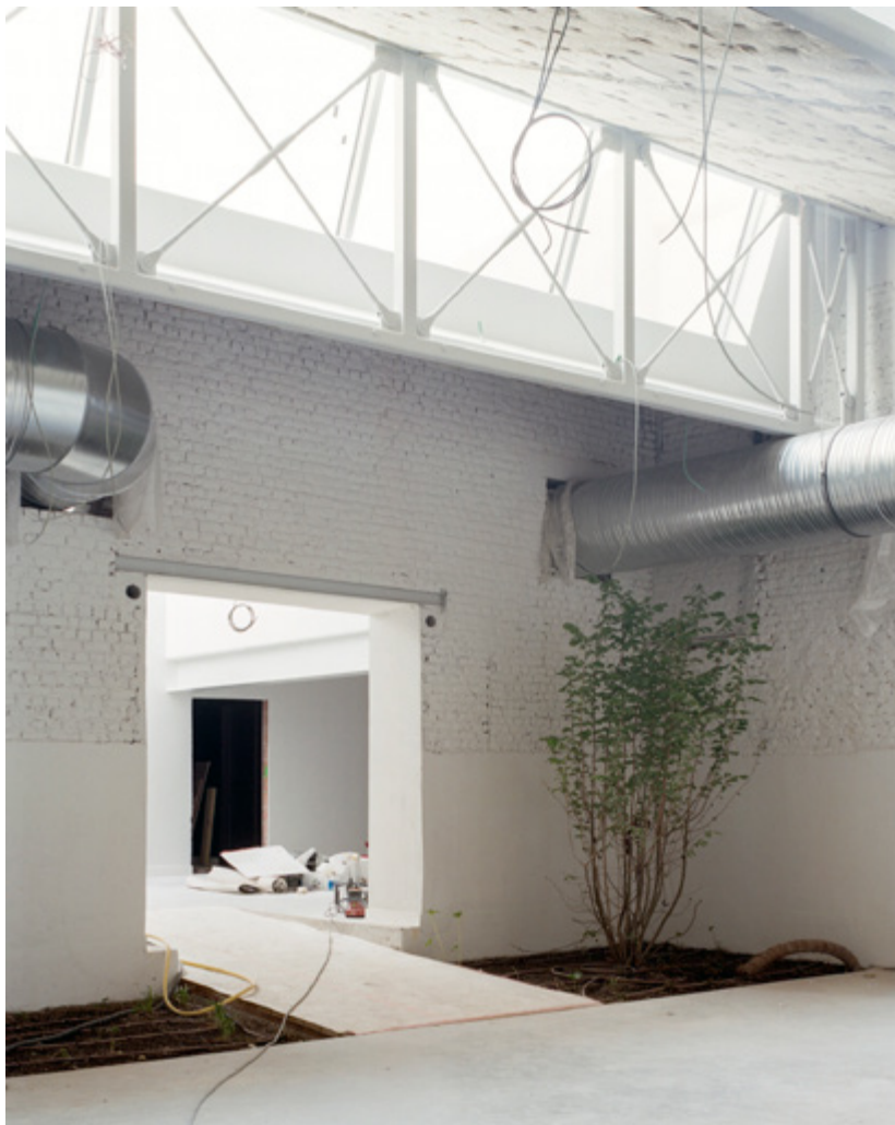
SB – pijler 2 en DWC “Pogge” in Schaarbeek, werf voor de verbouwing van de voormalige bioscoop Élite en het theater Scarabaeus tot een sociaal-culturele pool door OUEST architecture, foto 2025. Séverin Malaud © urban.brussels
