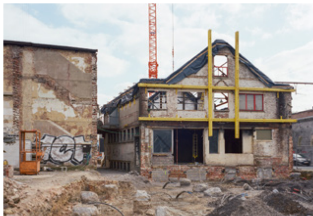
SVC 3 "Weststation" en SB – Pijler 2, werf voor de herinrichting van het voormalige Volkshuis in Anderlecht, opgenomen in de wettelijke inventaris sinds 19 augustus 2024, door Czvek-Rigby, foto 2025. Séverin Malaud © urban.brussels
