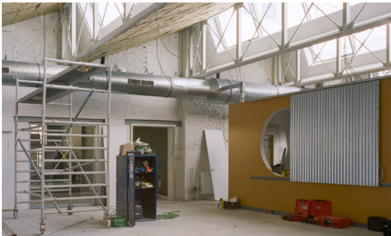
SB – Pijler 2 en DWC “Pogge” in Schaarbeek, werf voor de verbouwing van de voormalige bioscoop Élite en het theater Scarabaeus tot een sociaal-culturele pool door OUEST architecture, foto 2025. Séverin Malaud © urban.brussels
