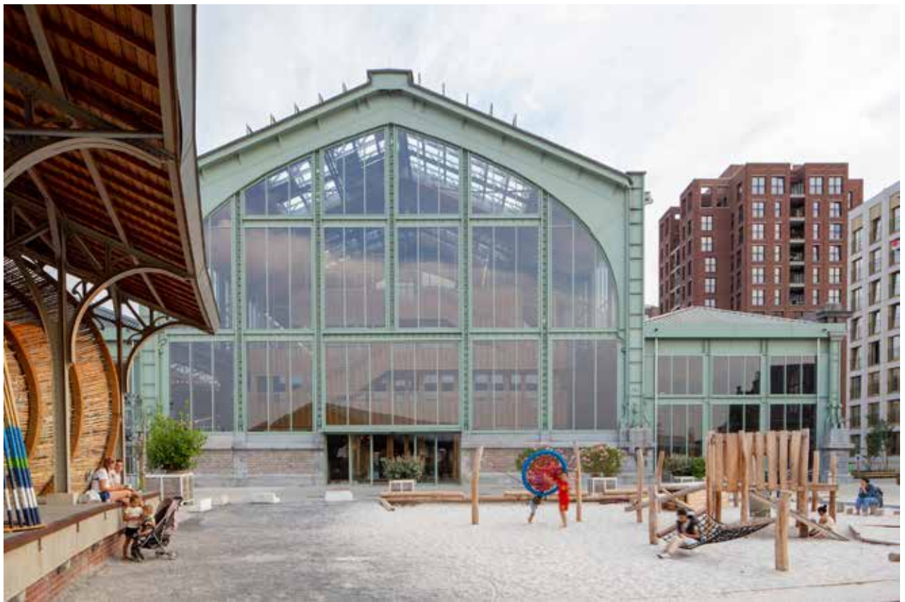
Gare Maritime op de site van Thurn & Taxis, door Neutelings Riedijk Architecten in samenwerking met Bureau Bouwtechniek, foto 2022. Séverin Malaud © urban.brussels
