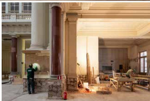
Restauratie en herbestemming van de Beurs van Brussel, beschermd sinds 19 november 1986, foto 2021. Séverin Malaud © urban.brussels
