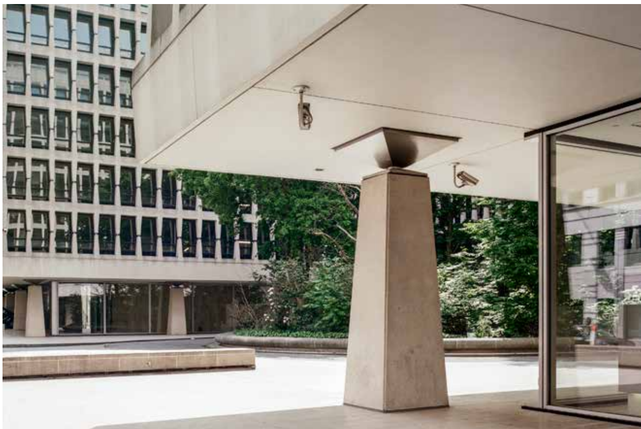
Voormalig hoofdkantoor van de Bank Lambert, Marnixlaan 24 in Brussel, opgenomen in de bewaarlijst sinds 18 maart 2021, foto 2022. Séverin Malaud © urban.brussels
