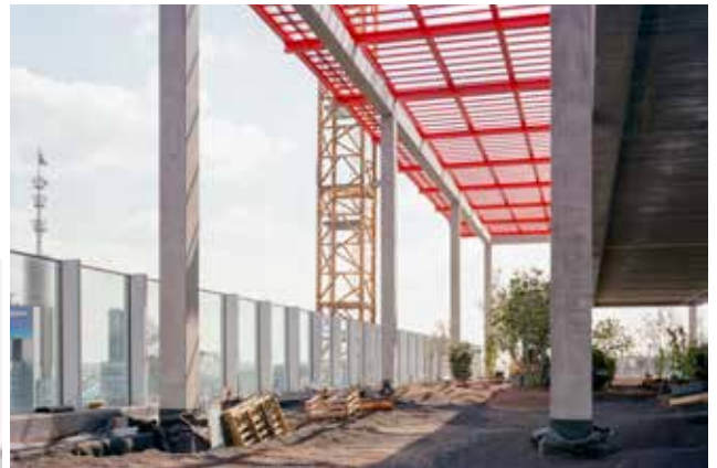
ZIN-project – Renovatie en transformatie van de torens 1 en 2 van het WTC-complex door Jaspers Eyers + 51N4E + l'AUC, laureaat be.exemplary 2019, foto van de bouwplaats 2023. Séverin Malaud © urban.brussels
