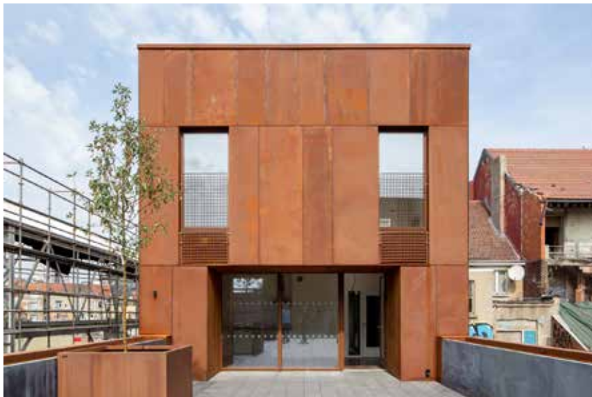
SB – Pijler 2 en DWC 'Zinneke' in Sint-Jans-Molenbeek – Werkplaatsen en intergenerationele woningen door B612 associates, foto 2022. Séverin Malaud © urban.brussels
