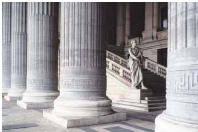
Palais de Justice de Bruxelles, classé depuis le 03 mai 2001, détail de la colonne du péristyle donnant sur l'escalier monumental. Ch. Bastin & J. Evrard © urban.brussels
