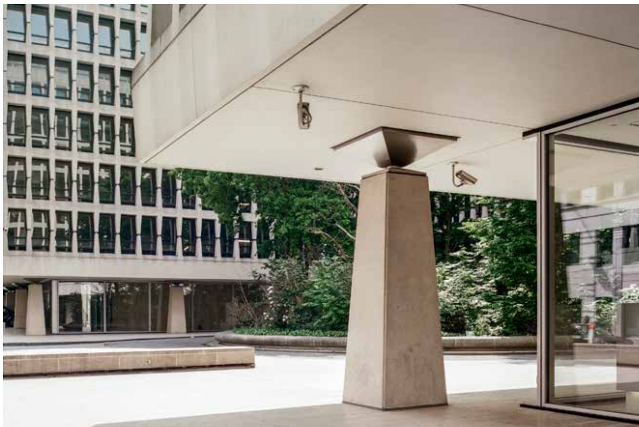
Ancien siège de la Banque Lambert, boulevard Marnix 24 à Bruxelles, inscrit sur la liste de sauvegarde depuis le 18 mars 2021, photo 2022. Séverin Malaud © urban.brussels
