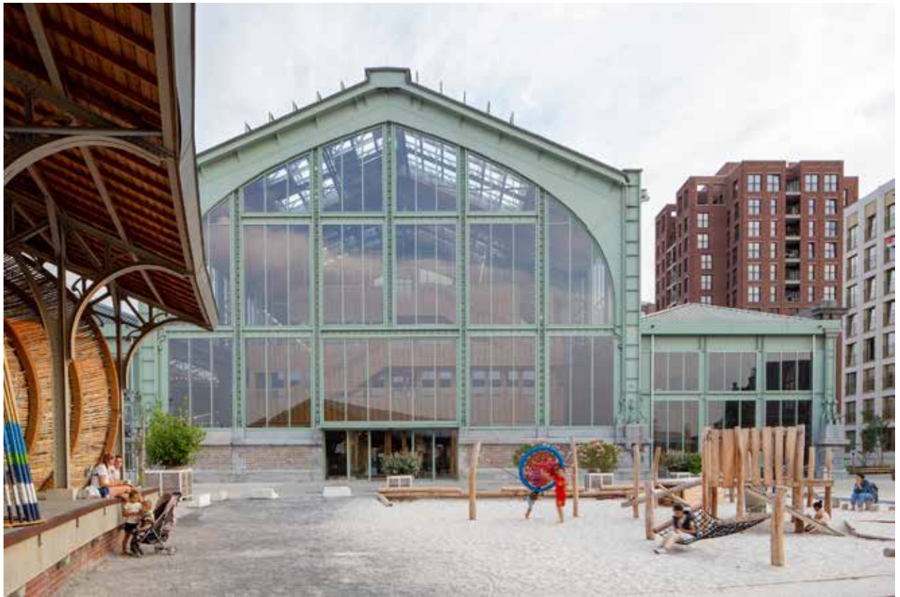
Gare Maritime sur le site de Tour & Taxis, par Neutelings Riedijk Architects en collaboration avec le bureau Bouwtechniek, photo 2022. Séverin Malaud © urban.brussels
