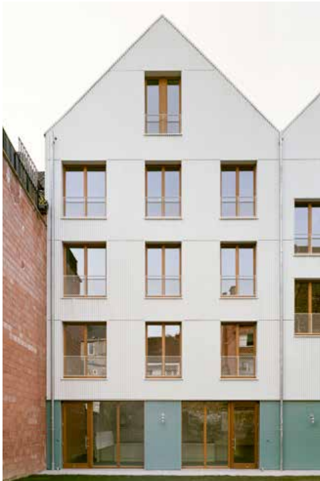
CQD « Reine-Progrès » à Schaerbeek – Maison Jolly, logements conventionnés diversifiés et salle polyvalente par EPOC architecture, lauréat be.exemplary 2019, photo 2022. Séverin Malaud © urban.brussels
