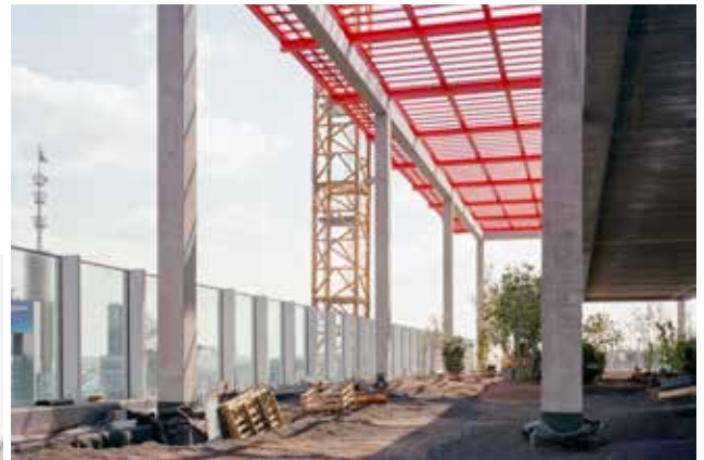
Projet ZIN – Rénovation et transformation des tours 1 et 2 du complexe WTC par Jaspers Eyers + 51N4E + l'AUC, lauréat be.exemplary 2019, photo de chantier 2023. Séverin Malaud © urban.brussels
