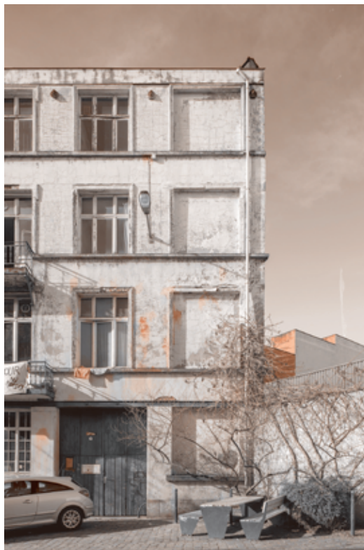
♦ SVC «Heyvaert - Poincaré» - Woningen Waskaarsstraat - Foto van de huidige situatie. Séverin Malaud © urban.brussels ▼ SVC «Koningslaan» - Toekomstige voedingshal op het binnenterrein van het huizenblok aan de Théodore Verhaegenstraat in Sint-Gillis. Op de benedenverdieping zullen artisanale productie- en verwerkingsateliers worden ondergebracht. Séverin Malaud © urban.brussels
